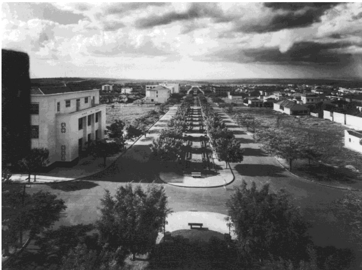
Figura 29: Foto da Avenida Goiás em 1945. Fonte: Museu da Imagem e do Som.
