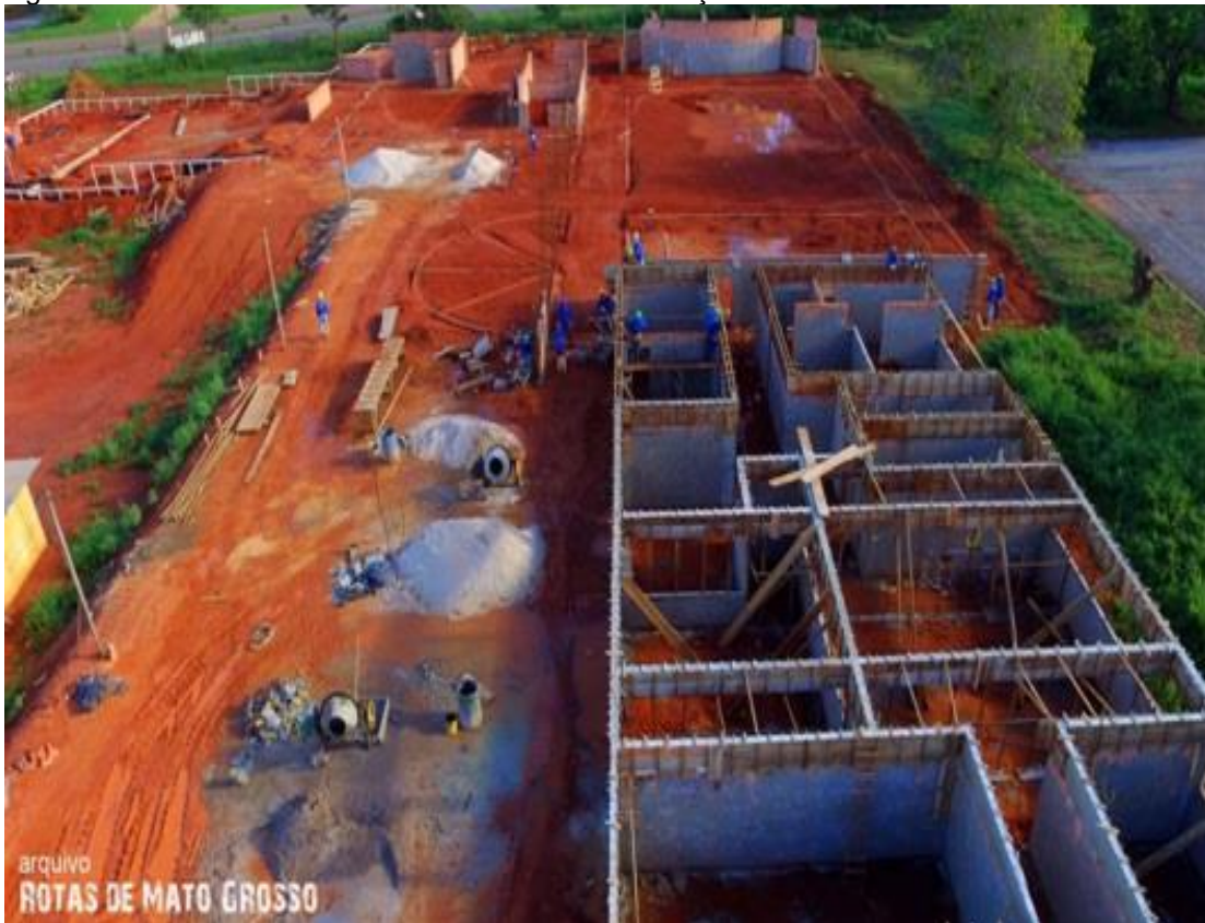
Figura 2: Obra do Centro de Eventos de Barra do Garças
