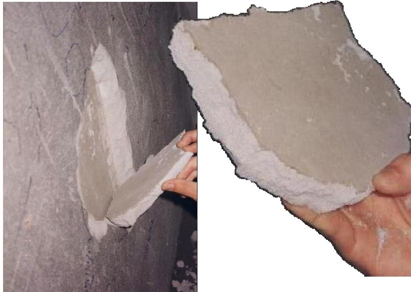
Figura 1.1 - Descolamento do revestimento em argamassa, em placas coesas, com ruptura na interface do chapisco com a estrutura de concreto (Bauer, 2002).
