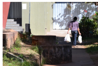
Figura 4.16 Passeio com obstrução em superquadra da Asa Norte. Fonte: acervo pessoal.
