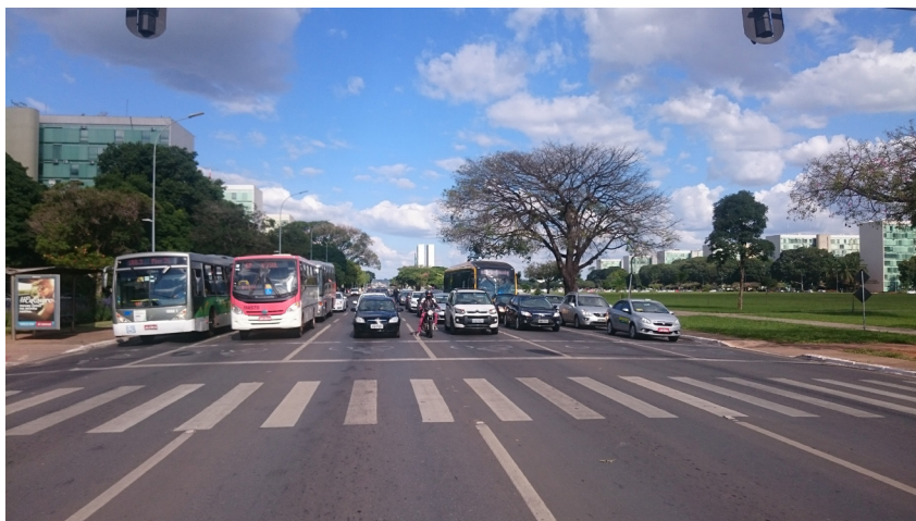
Figura 6.24 Imagem da Via Arterial N1 com suas seis faixas de circulação.
