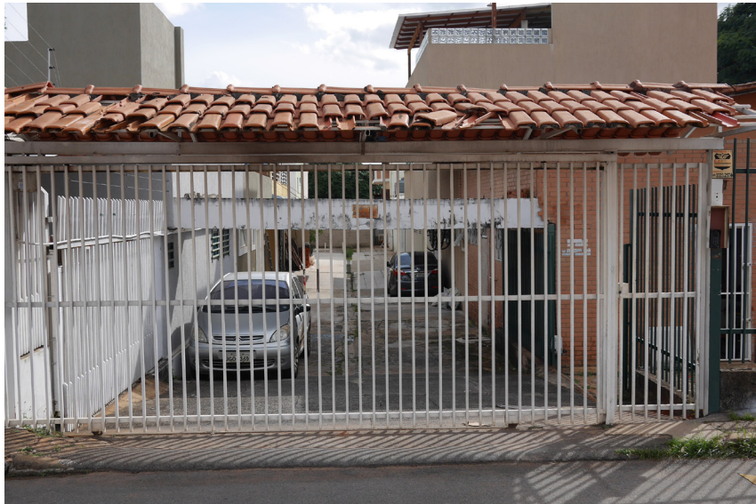
Figura 6.48 Área de passagem transformada em garagem no setor de habitações individuais.
