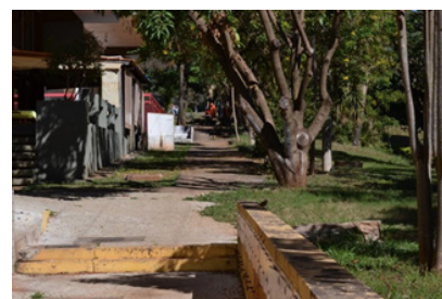
Figura 4.17 Passeio com desnível e desvio em superquadra da Asa Norte. Fonte: acervo pessoal.
