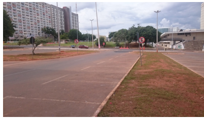
Figura 6.15 Antes e depois em área adjacente à Via S2.
