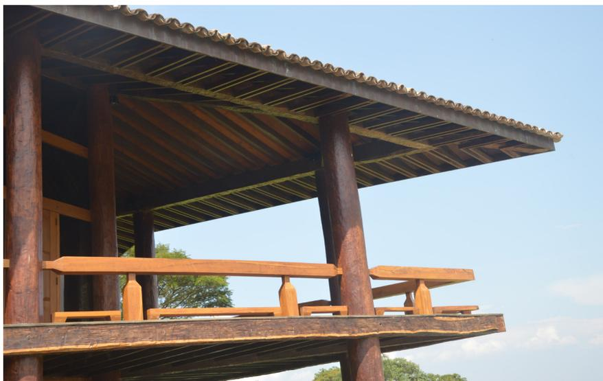
**85.** Detalhe do forro no bloco principal, em que se percebem a diferença de inclinação proporcionada pelos “cachorros”. Fonte: Giselle Chaim.
