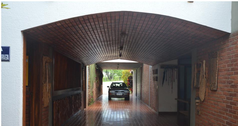
**104.** Devido ao tratamento do terreno, Zanine criou um acesso de serviços sob a plataforma elevada em madeira como um túnel arqueado revestido em blocos cerâmicos interrompido por aberturas por cima e aos lados, que garantem ventilação e iluminação natural à área. Fonte: Giselle Chaim.
