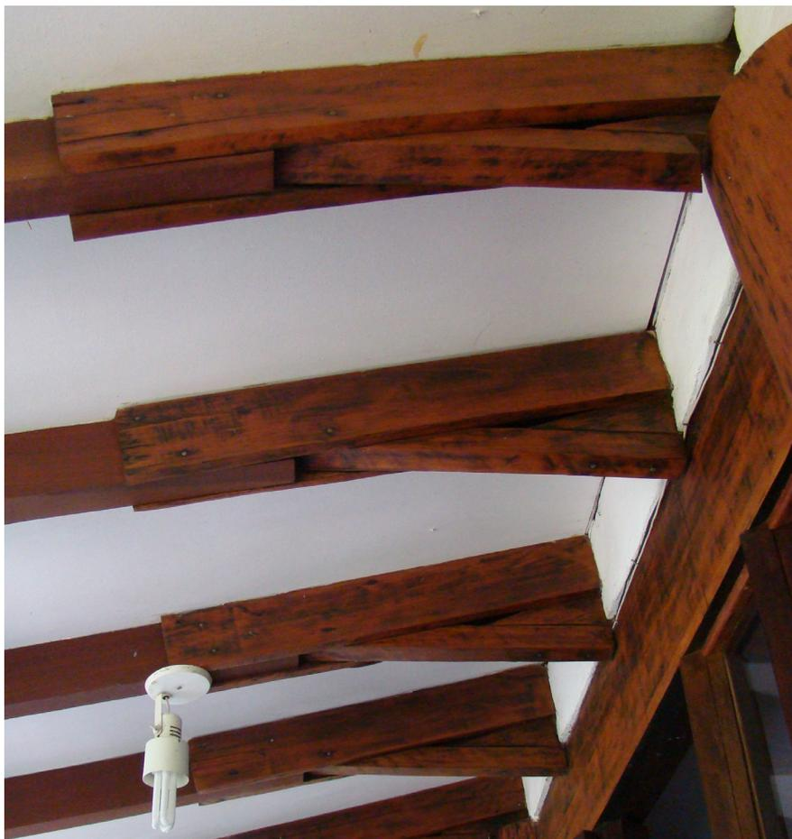
**115.** Detalhe do forro no bloco principal, em que se percebem a diferença de inclinação proporcionada pelos “cachorros”. Fonte: Giselle Chaim.
