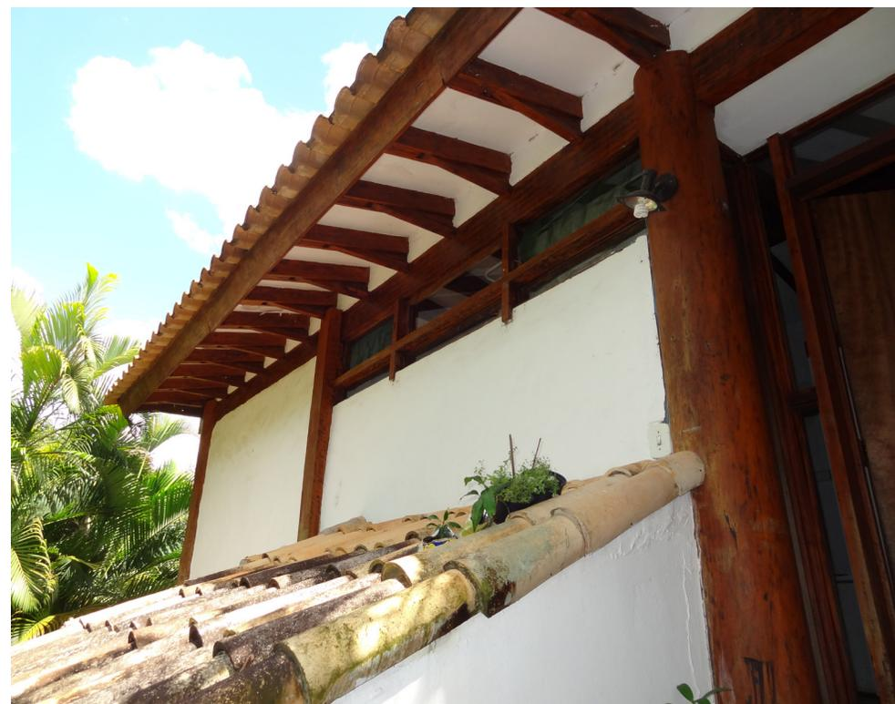
**117.** Detalhe dos beirais na fachada lateral esquerda e dos “cachorros” em madeira que alteram a inclinação das águas nas pontas, fator que mais marca a influência oriental no telhado da casa Collor. Fonte: Giselle Chaim.
