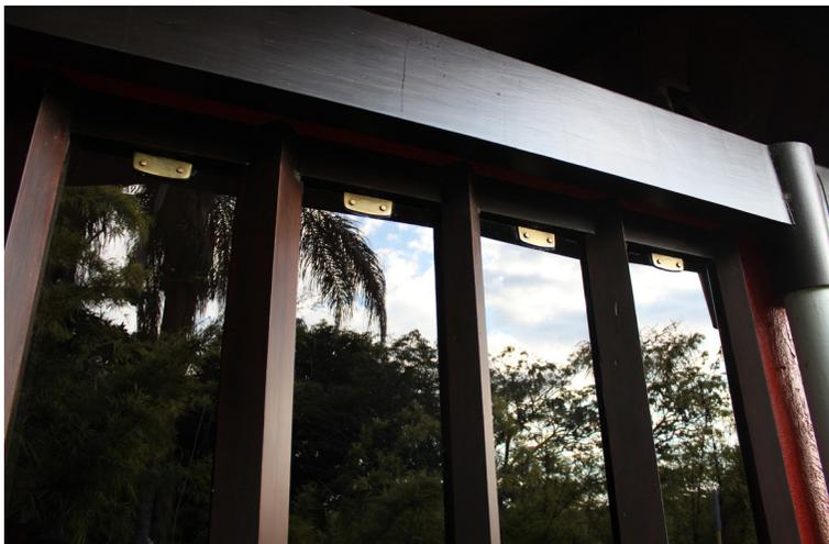
**160.** Janelas de áreas de serviços em painéis de vidro pivotantes entre peças em madeira giradas a 45 graus.
