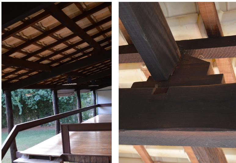
**62.** Varanda com situação atual de cobertura aparente. Verificou-se a substituição das telhas originais e reparos que indicam possível destelhamento e alteração de inclinação, provavelmente devido a reformas ao longo do tempo. Fonte: Giselle Chaim.
