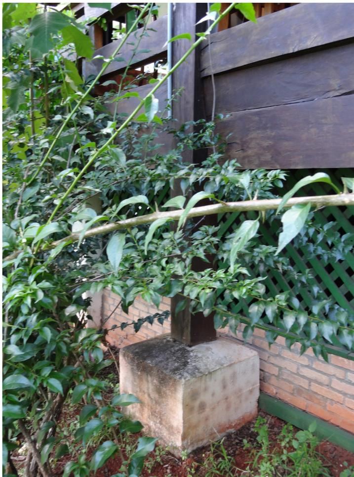
**112.** Detalhe do complemento em concreto armado necessário para apoio dos pilares pré dimensionados em madeira para vencer a altura na fachada principal. Nessa foto, fica evidente o aterramento do terreno para esconder as estruturas em concreto da fachada principal.
