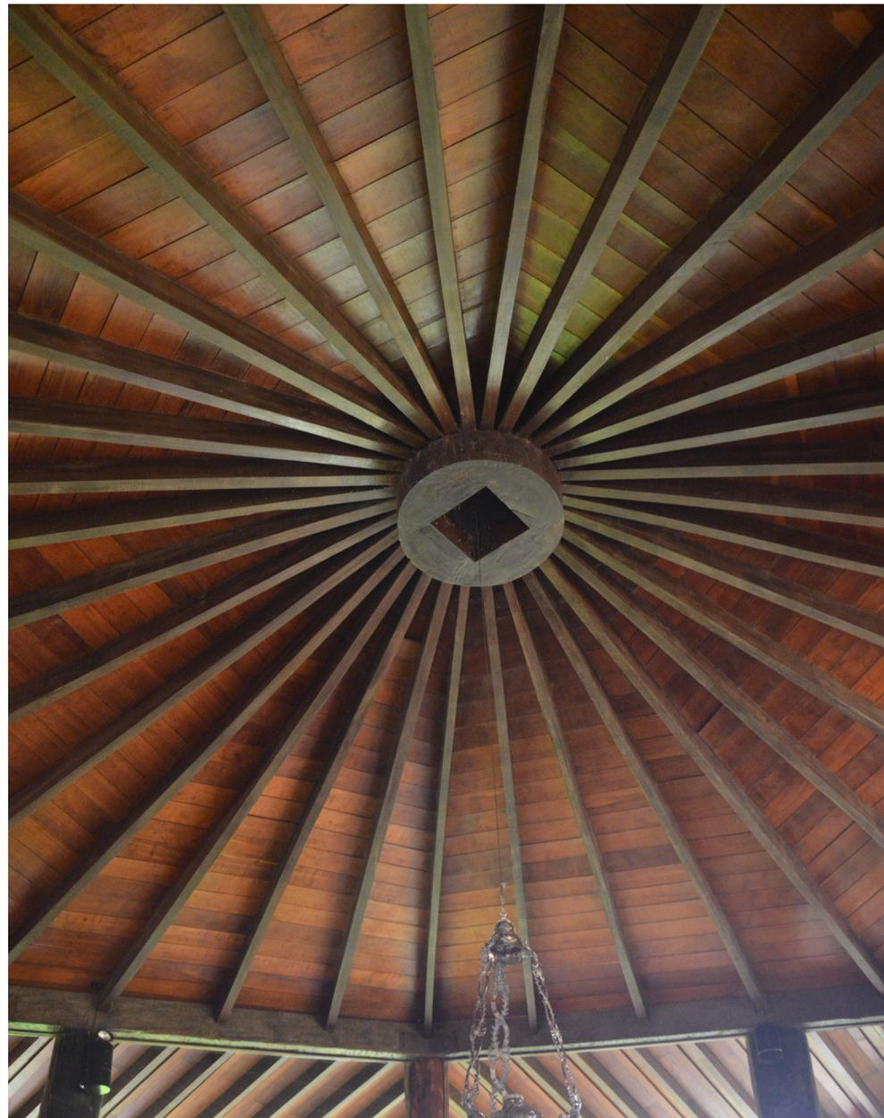
**87.** Detalhe do forro em ipê do bloco principal, onde se localiza o salão de estar do pavimento superior. Os dois anéis de tração - maior e menor - recebem as vigas em madeira que estruturam o grande vão central e lembram a estrutura de carros de boi. Fonte: Giselle Chaim.
