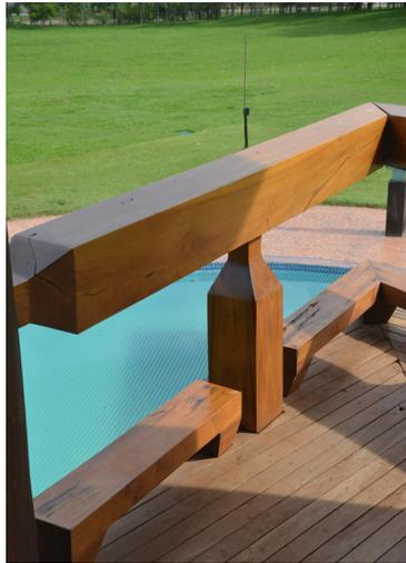
**97.** Detalhe do guarda-corpo esculpido em madeira, que tem o detalhe para apoio dos pés ao se apoiar para apreciar a vista do Lago Paranoá.
