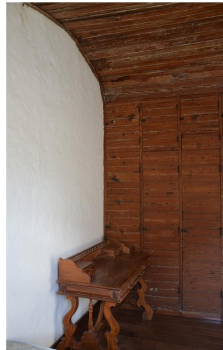
**65.** No quarto, localizado na área de expansão da residência, o forro se transforma nas portas do armário fixo, em pinho-de-riça de demolição.
