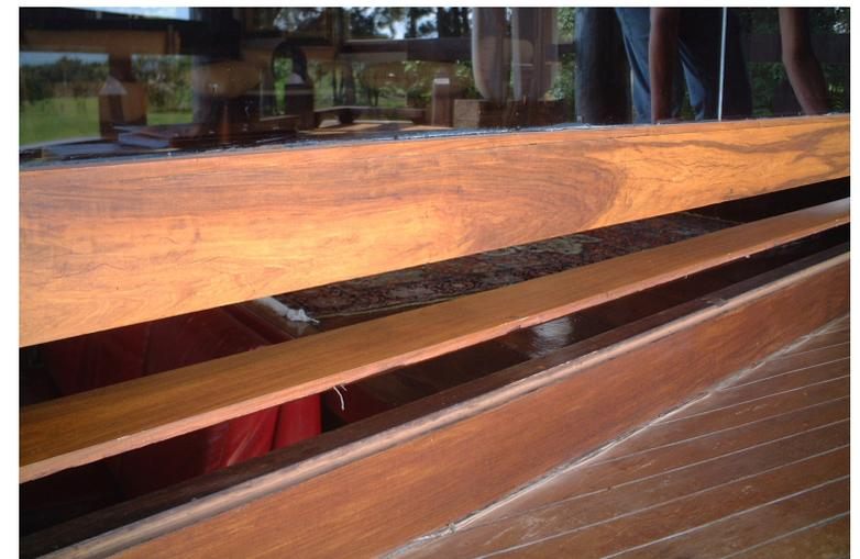
**94.** Abertura para ventilação natural nos painéis de vidro da sala de estar do pavimento superior. Fonte: Pedro Agostinho Miranda.
