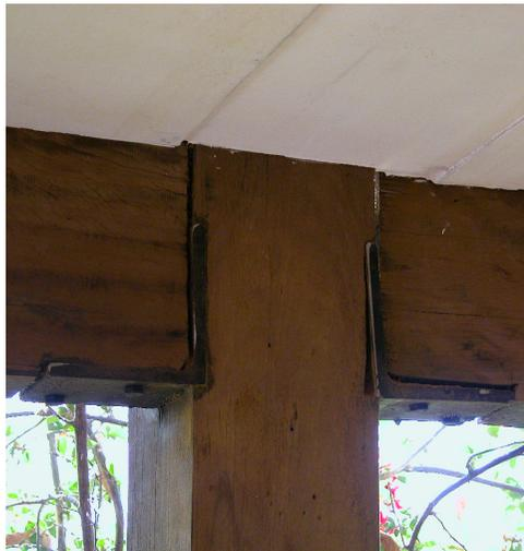
**127.** Detalhe dos encaixes entre as peças de madeira.
