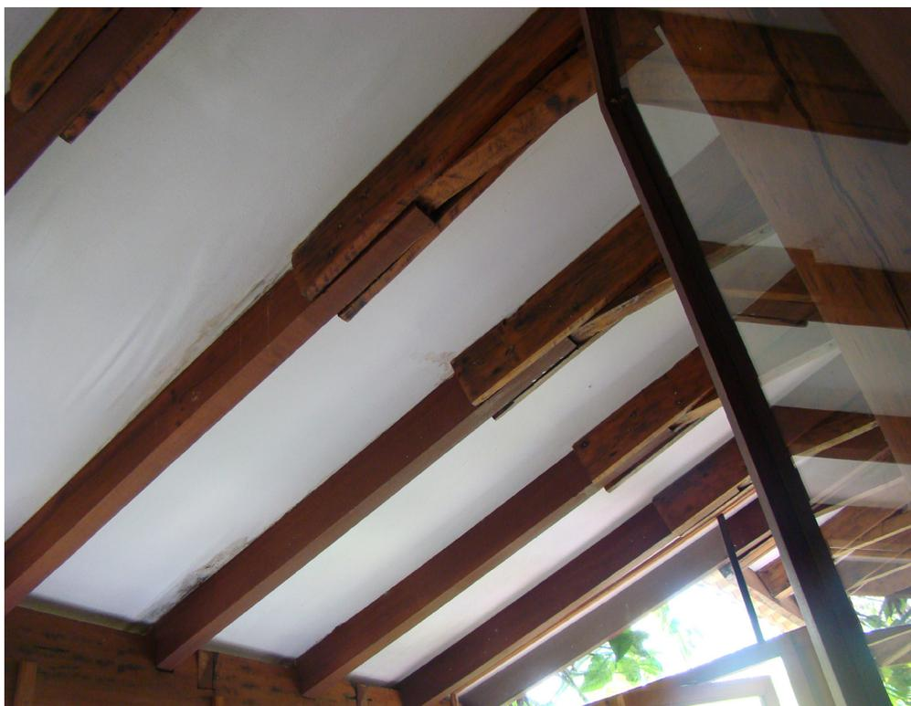
**116.** Detalhe que mostra as conexões entre as peças de madeira que estruturam a cobertura.
