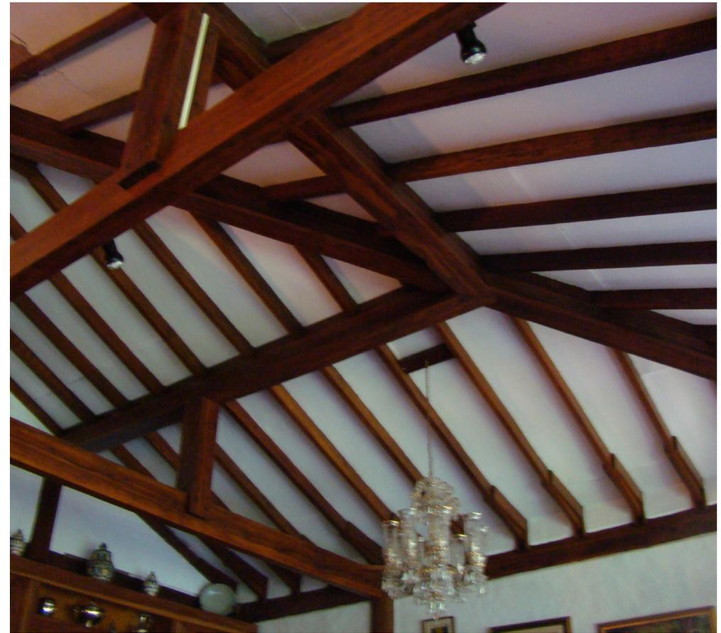
**114.** Detalhe dos caibros em madeira, espaçados entre si a cada 50cm, e das demais estruturas em madeira para sustentação do telhado. Entre eles, o forro em compensado pintado de branco. Fonte: Giselle Chaim.
