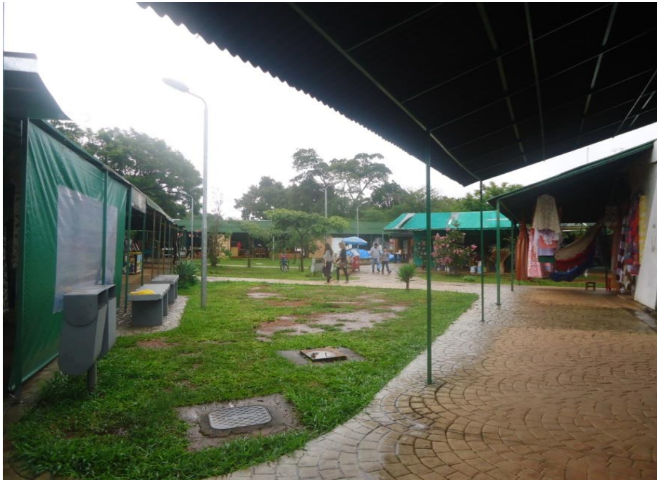
Figura 34 - Espaço entre blocos com sentido de labirinto
