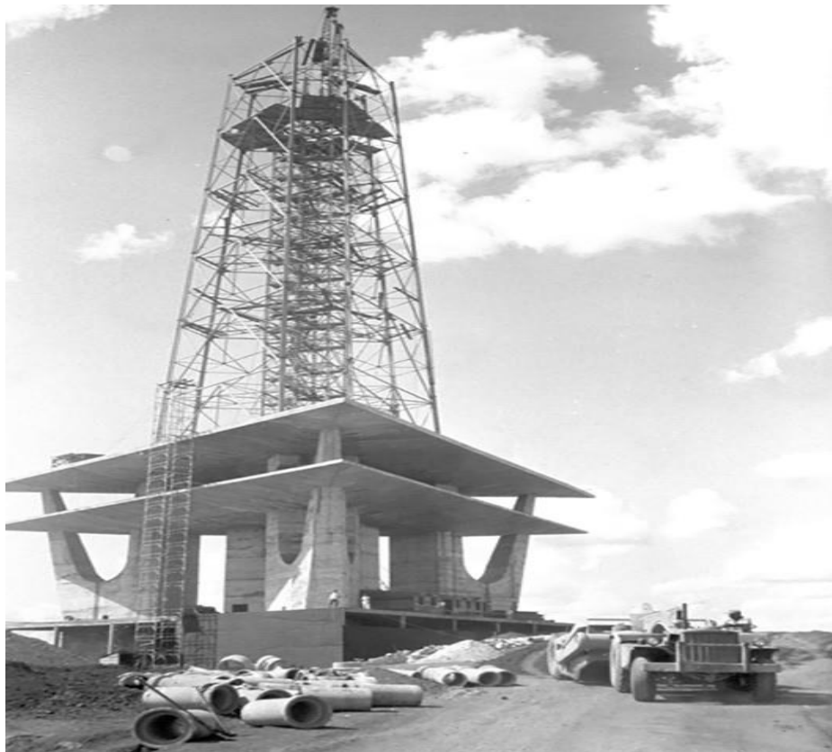
Figura 16 – Obra da Torre de TV
