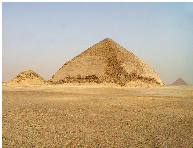
FIGURA 93: Ao centro, a pirâmide truncada de Dashur e, ao fundo e a direita, a pirâmide vermelha. Observa-se que a primeira altera o ângulo de inclinação na altura da metade de seu volume 237 .
