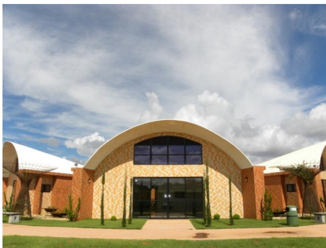
FIGURA 346: Fachada frontal das capelas. FONTE: Idem.
