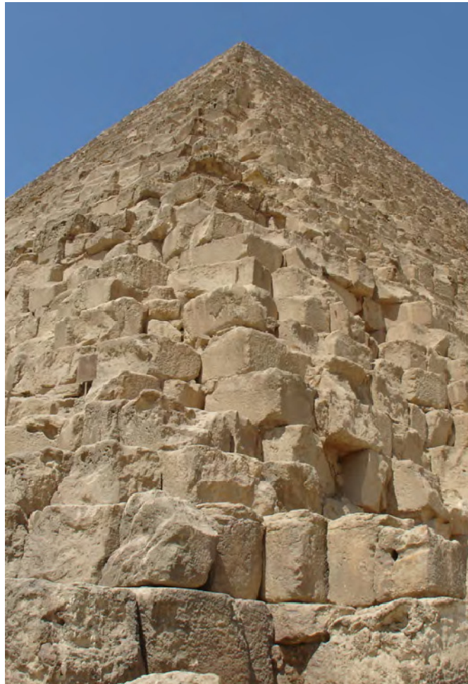
FIGURA 104: Pormenor da pirâmide de Quéfren: os blocos de calcário procediam das pedreiras de Tura, eram transportados em embarcações pelo Nilo e arrastados até a base da construção 248 .
