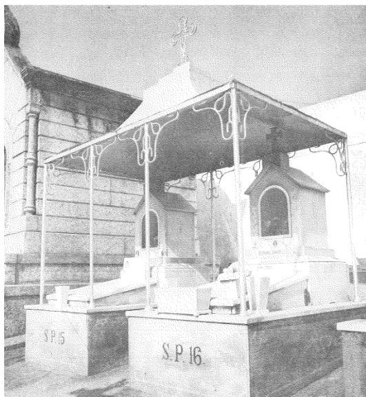
FIGURA 245: Túmulo construído com tubos de ferro e cobertura de metal. Cemitério do Catumbi, Rio de Janeiro. FONTE: VALLADARES, 1972, p. 1073.
