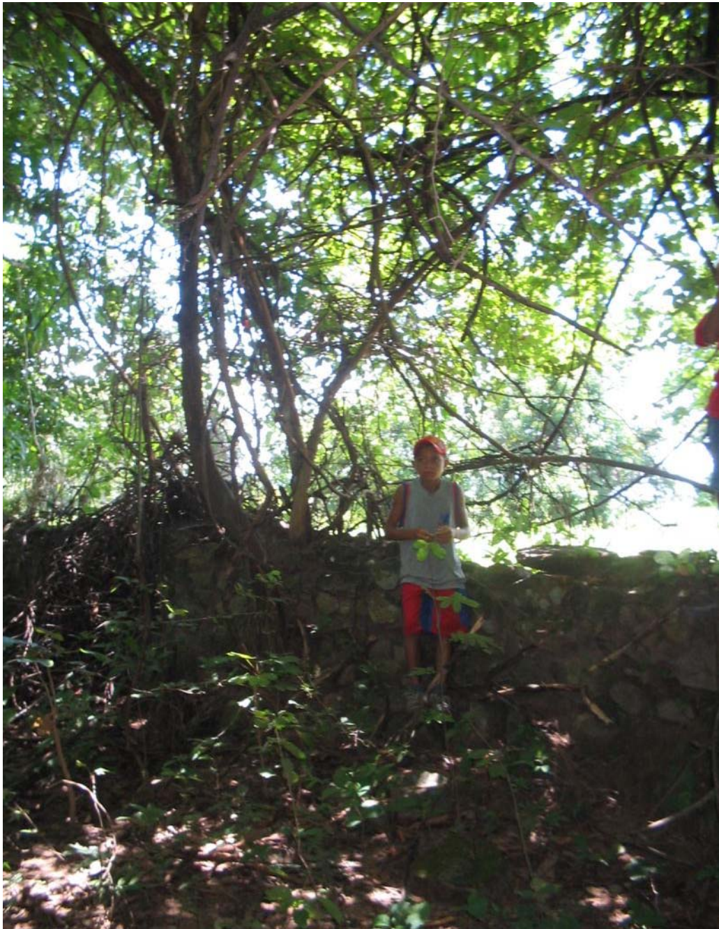
Foto 9: Muro de pedra
