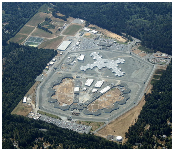
Figura 7 – Fotografia da USP Pelican Bay (EUA) Representativa do padrão arquitetônico modular. A fotografia mostra a modulação do padrão em pavilhões. (Disponível em: < https://en.wikipedia.org/wiki/Pelican_Bay_State_Prison >. Acessado em: fev. 2017)
