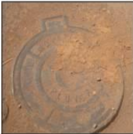
Figura 5: Poço de Visita da drenagem pluvial em via pavimentada por asfalto.
