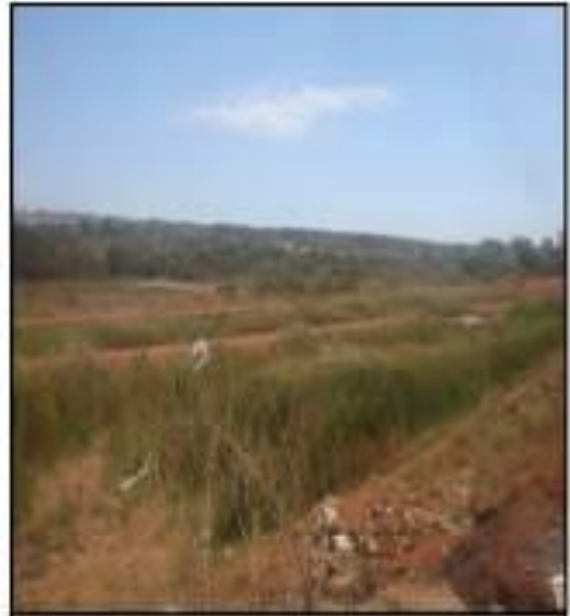
Figura 9: Bacia de detenção das águas pluviais da Vila Estrutural.
