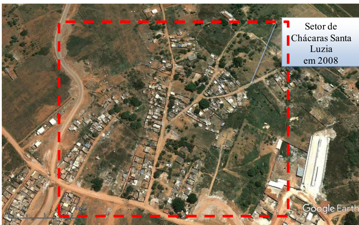
Figura 31 – Extrato da imagem da Estrutural 2008 – destaque para as ocupações no Setor de Chácaras Santa Luzia. Fonte da imagem: Google Earth
