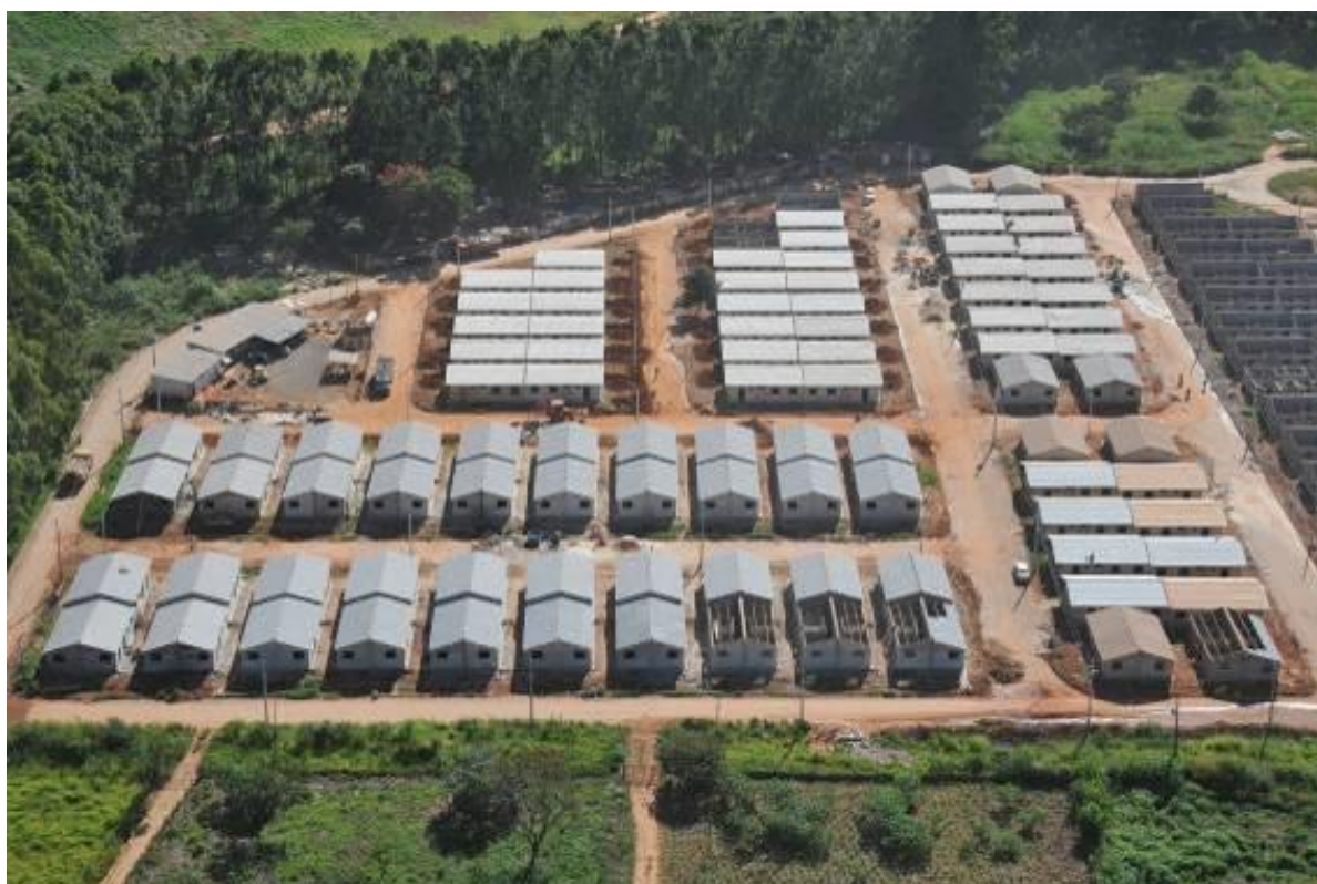
Figura 33 - Detalhe das casas construídas pelo Programa Minha Casa Minha Vida. Fonte da imagem: CODHAB
