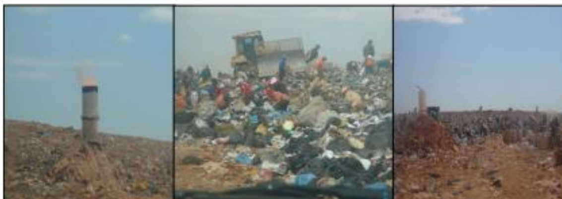
Figura 32: A situação do Aterro Sanitário do DF – LIXÃO da Estrutural, com a presença dos catadores, cachorros, urubus, pombos e ducto de gás em chama.
