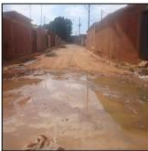
Figura 29: A ausência de drenagem pluvial nas vias internas tem causado acúmulo de água no parcelamento.
