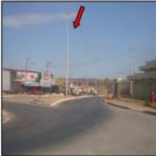
Figura 2: Via viária pavimentada com asfalto em grande parte do parcelamento, rede de distribuição de energia elétrica operada pela CEB, sinalização, calçadas e meios-fios.
