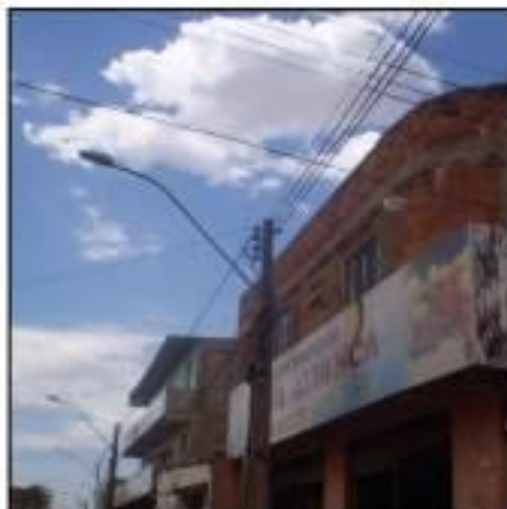
Figura 31: Residências de 2 e 3 pavimentos em área comercial sem respeitar a distância mínima da rede de distribuição e sem padrões de segurança.
