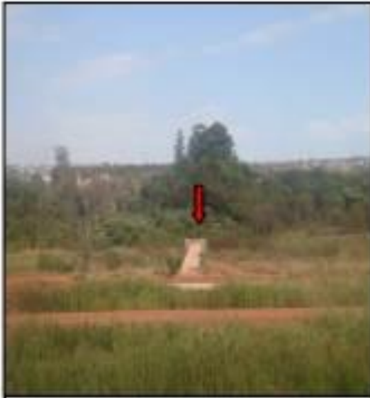
Figura 8: Dissipador da bacia de detenção do parcelamento Vila Estrutural.
