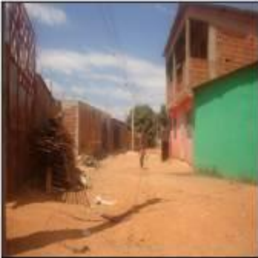
Figura 12: Via interna não asfaltada na Vila Estrutural.
