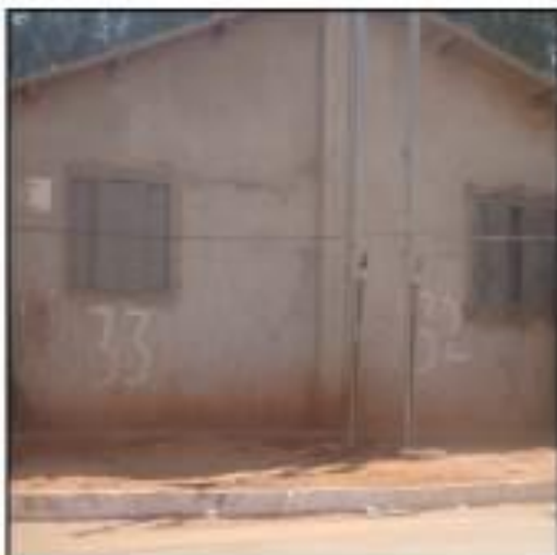
Figura 30: Residências geminadas entregues à população da Vila Estrutural, sem calçamento e sem muro.
