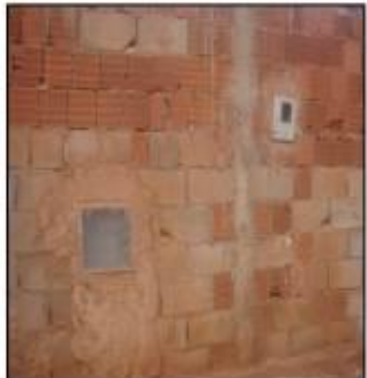
Figura 11: Relógio da rede de água – CAESB e relógio de energia elétrica – CEB no muro de uma residência.
