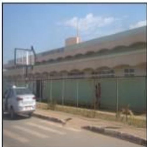
Figura 18: Centro de Saúde da Vila Estrutural.
