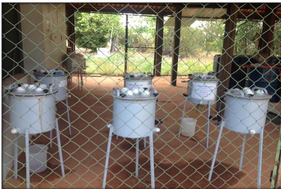
Figura 4: Foto do armazenamento do óleo Diesel S500 A e B nos tanques.
