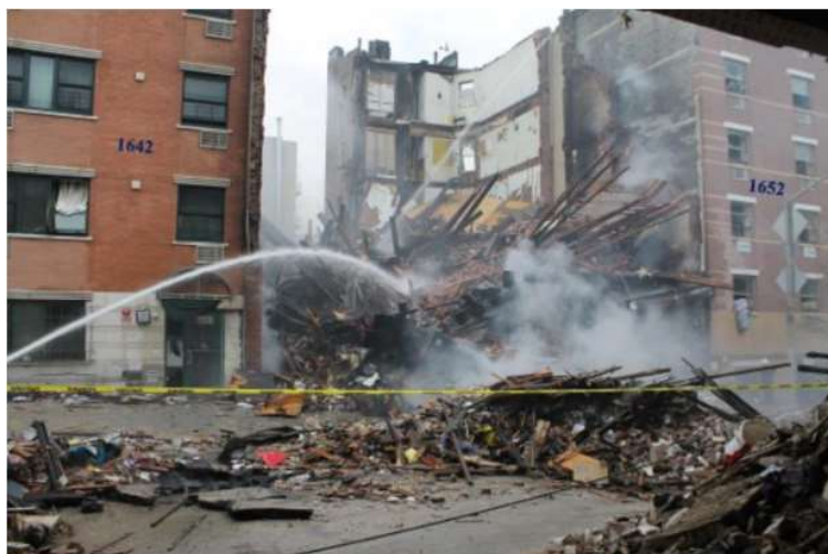
Figura 2.13. Edifício destruído devido à explosão de gasoduto em Manhattan, New York City (NTSB, 2014).
