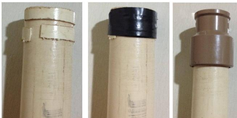
Figura 38: montagem d final do tubo de 40.
