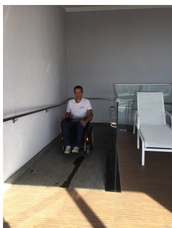
Figura 93 – Rampa de acesso ao Spa escada de acesso a piscina na área de lazer da torre residencial. Fonte: autora
