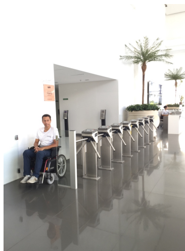
Figura 87 – Porta para acesso PMR da recepção no hall da torre comercial. Fonte: autora
