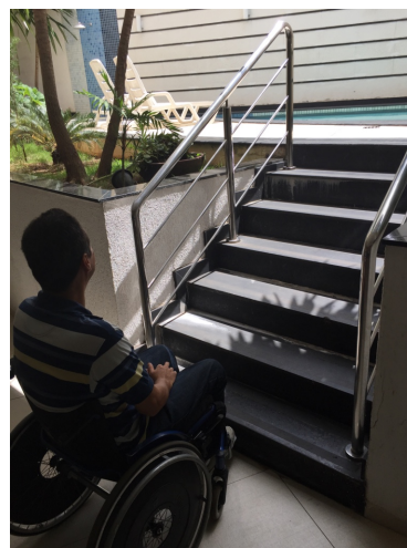
Figura 53 – Desnível na escada para acesso da piscina e. Fonte: autora.
