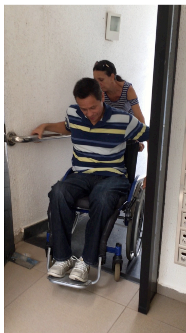
Figura 49 – Acesso pela rampa com inclinação irregular. Fonte: autora
