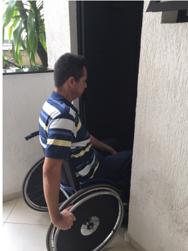
Figura 54 – Desnível na porta de acesso para a instalação sanitária com largura insuficiente de passagem. Fonte: autora
