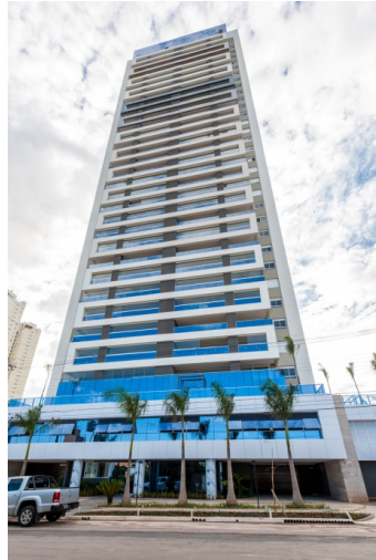
Figura 3 – Edifício de múltiplo uso construído em 2014 na cidade de Goiânia. Fonte: http://opusic.com.br/imovel/park-line-urban-house/
