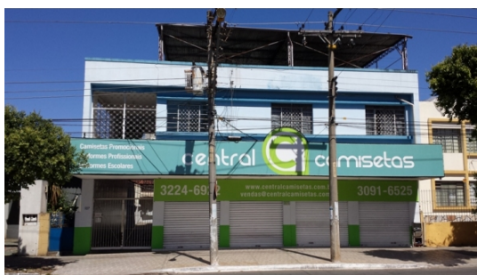
Figura 1 – Edifício antigo de múltiplo uso na cidade de Goiânia. Construído em meados de 2000. Fonte: http://www.leonardolobo.com.br/imovel/codigo/4764
