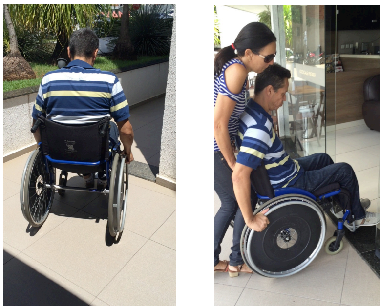
Figura 48 – Desnível na paginação do pavimento térreo. Fonte: autora
