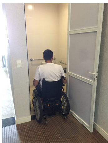
Figura 91 – Porta da instalação sanitária na área de lazer da torre residencial. Fonte: autora
