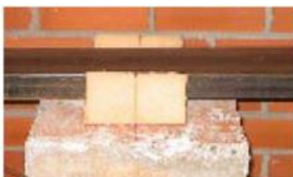
Figura 5.13 – Detalhe do apoio da viga.
