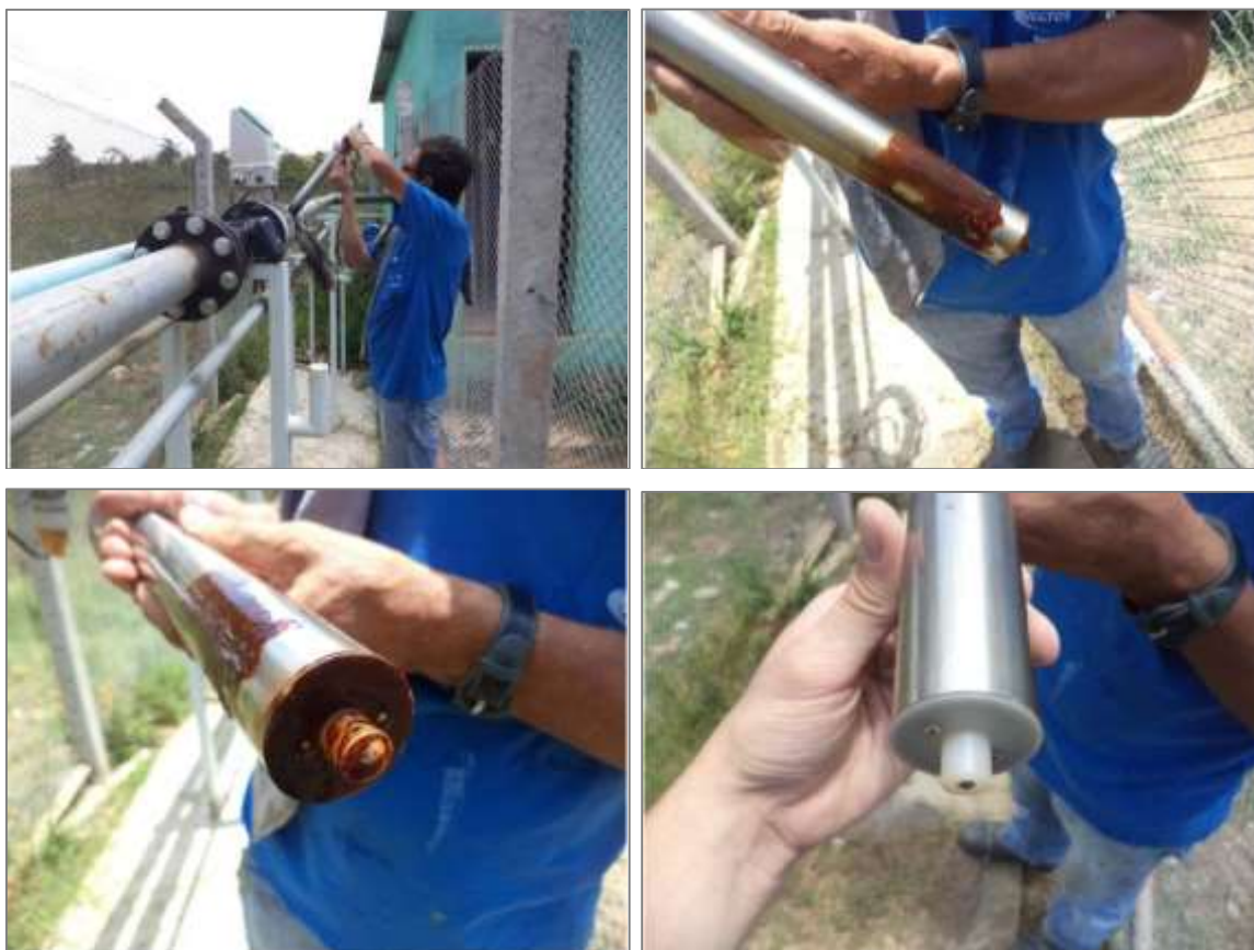
Figura C.22 – Estação 2 – Areal: retirada e limpeza do medidor de inserção
