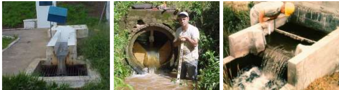
Figura 3.17 – Vertedouro retangular (esq.), triangular (centro) e trapezoidal (dir.)
