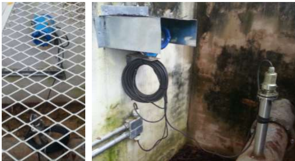
Figura C.19 – Estação 1 – Mazurek: Display do eletromagnético sem proteção (esq.) e com chapa de alumínio protegendo contra intempéries (dir.)
