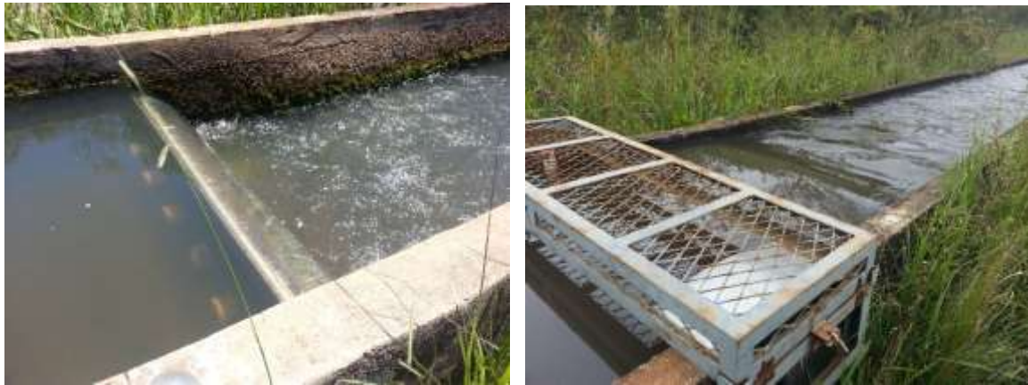
Figura C.36 – Vertedouro em regime de operação normal (esq.), em 23/10/2015, e vertedouro afogado na 2 a quinzena de fevereiro de 2015 (dir.), foto tirada em 19/02/2015
