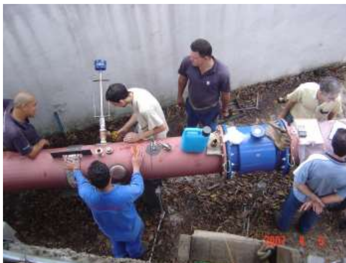
Figura 3.4 – Equipamentos eletromagnéticos de inserção (esq.) e carretel (dir.)
