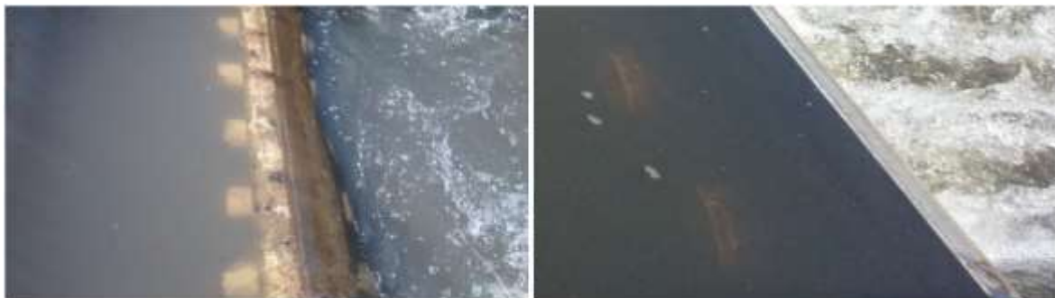
Figura C.37 – Vertedouro sem a crista de alumínio (esq.), e com a crista reinstalada (dir.)
