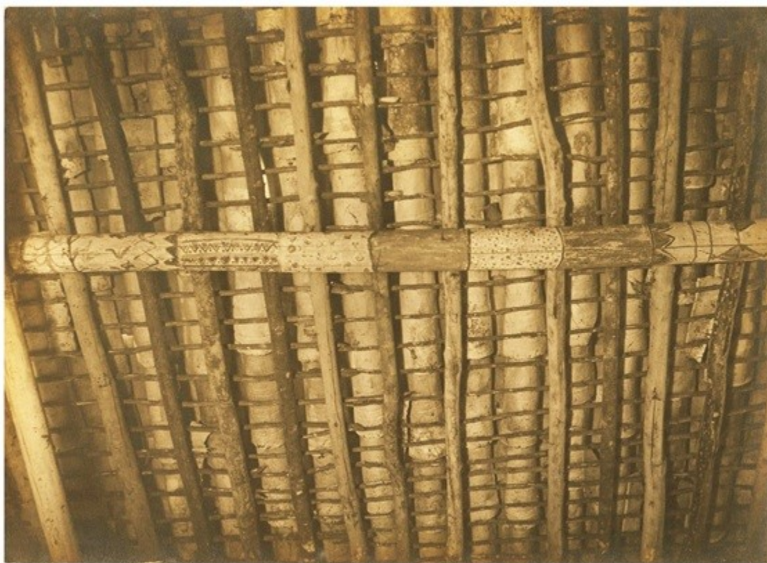
Figura 26: Detalhe da terça decorada, mestiça, com desenhos indígenas e que teria sido obtida possivelmente do mastro que sustentava as bandeiras das festas religiosas na Aldeia de Carapicuíba.
