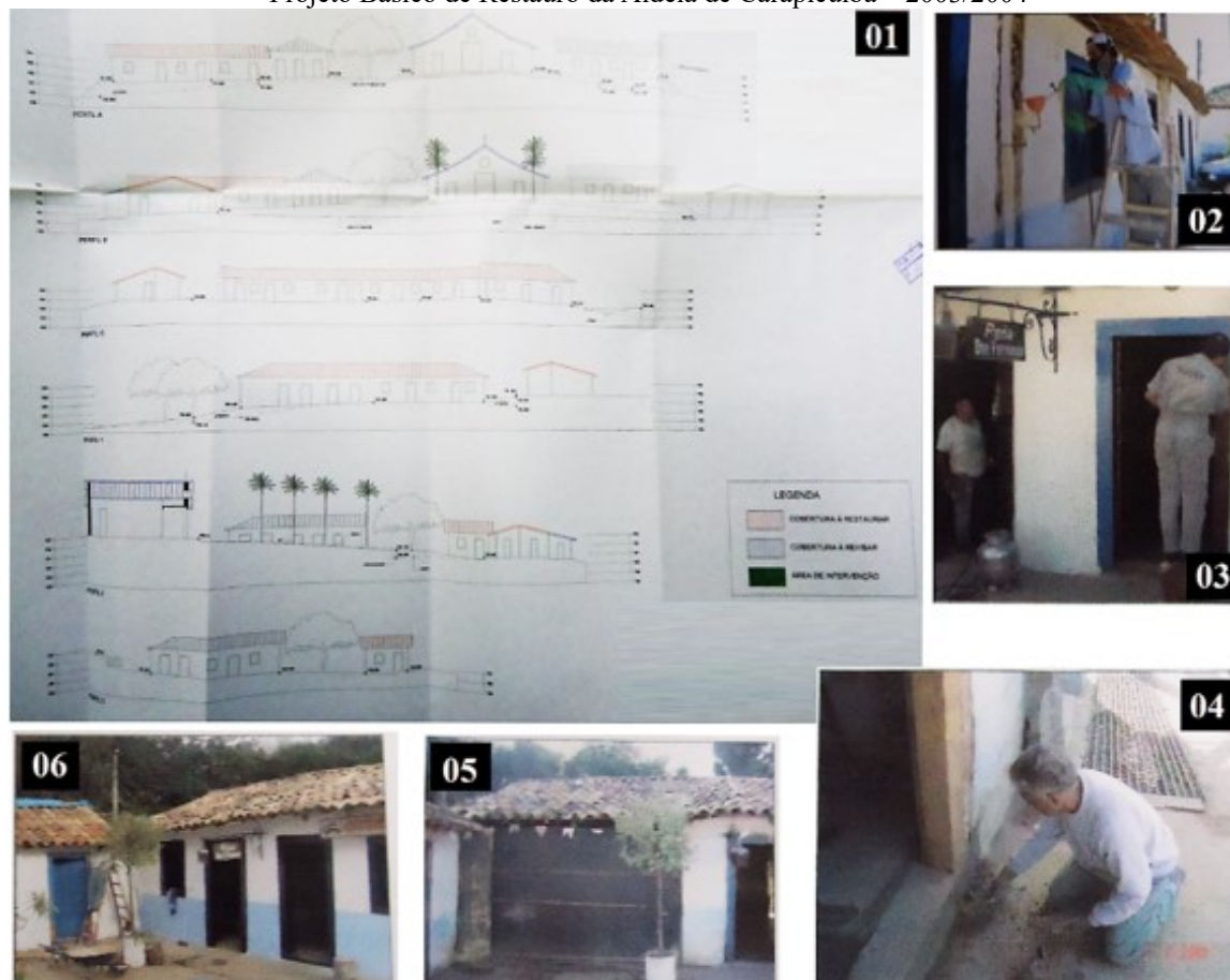
Figura 46: (1) Perfis das faces de intervenção do conjunto da Aldeia de Carapicuíba; (2) Aplicação de cupinicida; (3) Pintura de portas e janelas; (4) Restauro de batentes e soleiras; (5) Fachada casas 01 e 02 como encontrada antes da execução do projeto; (6) Fachada após reconstrução e restauro – 2004. Recursos Minc/SE/FNC.
