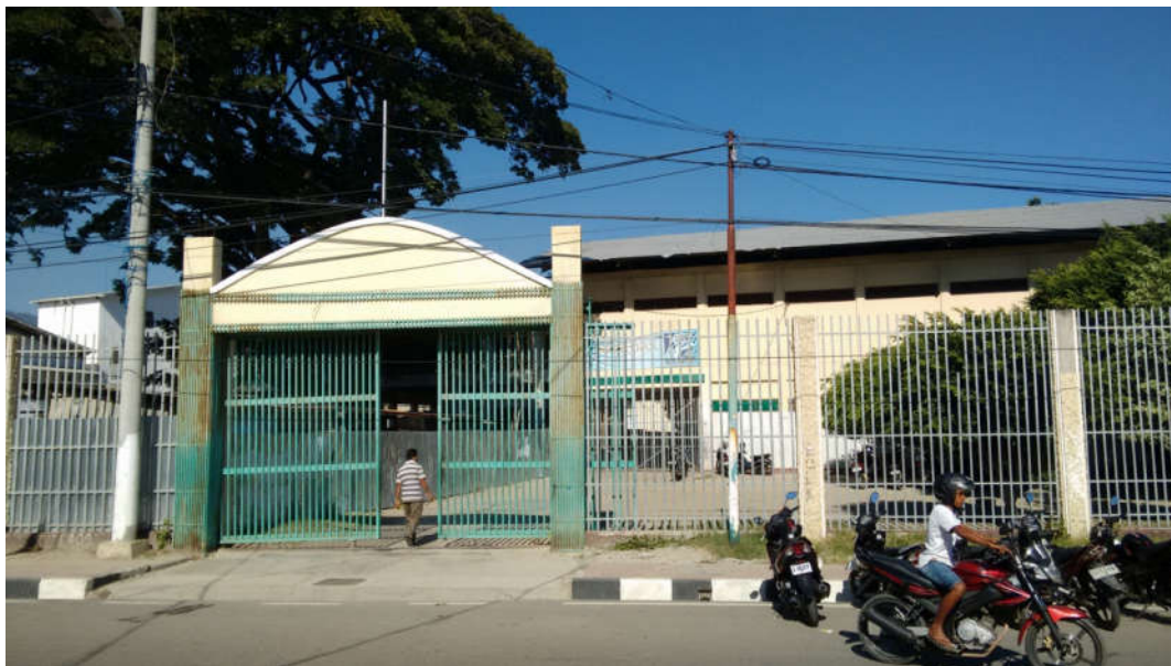
Figura 14. Fotografia da fachada da Escola João XXIII em Audian - Díli
