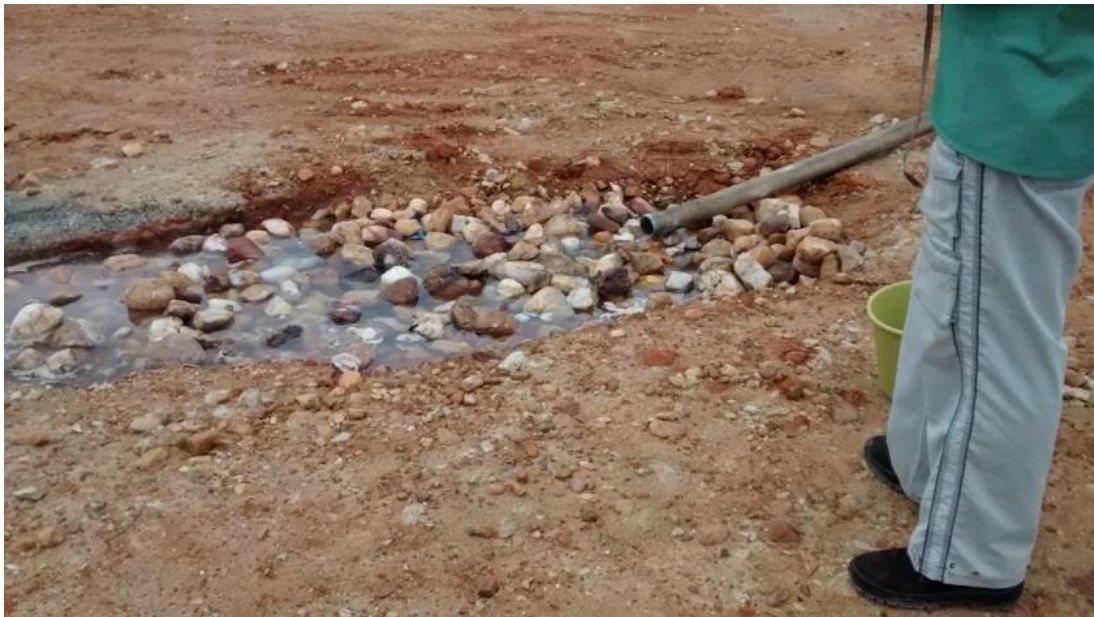
Figura 4.11 - Água sendo injetada pelo caminhão pipa diretamente na trincheira no Sistema Piloto da Escola Municipal. A camada de xisto presente próximo à superfície se comportou como uma barreira hidráulica não permitindo que a água infiltrasse e chegasse à fratura monitorada pelo poço.
