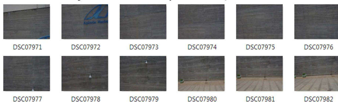
Figura 134 – Linha de voo 4 do prédio da ANTAQ, fachada norte
