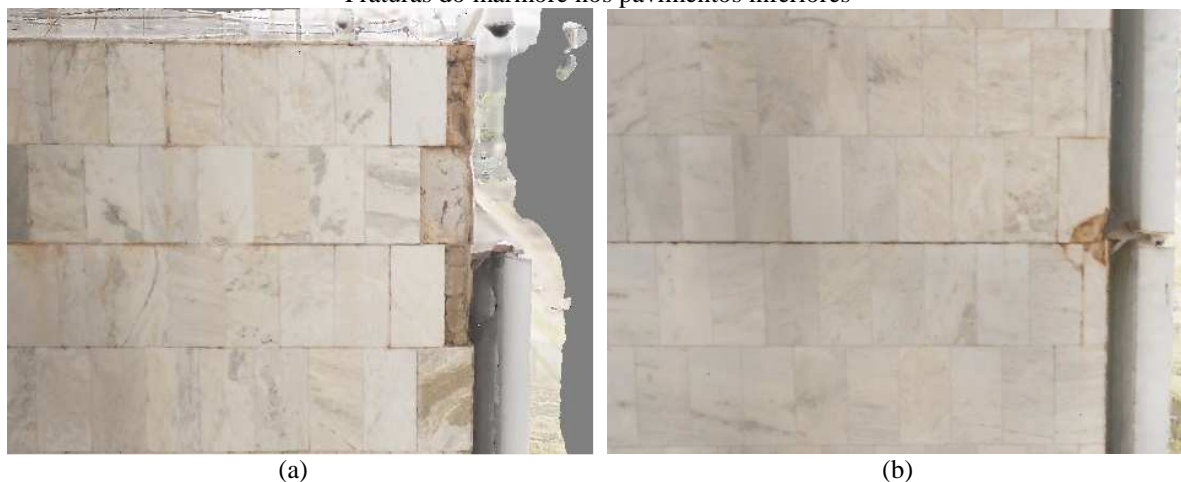
Figura 168 – Modelo 2-CN-S-E no PhotoScan: (a) Fraturas do mármore nos pavimentos superiores; (b) Fraturas do mármore nos pavimentos inferiores
