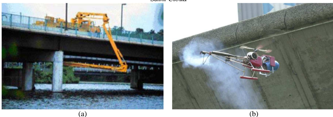
Figura 3 – (a) Plataforma para inspeções de fissuras em pontes; (b) Inspeção auxiliada por VANT no viaduto Saint Cloud
