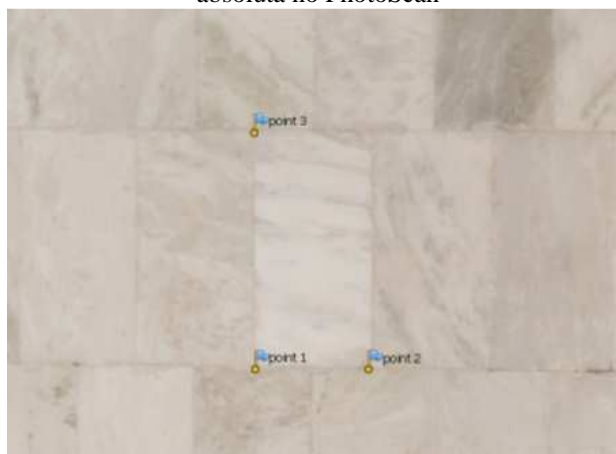
Figura 92 – Especificação de marcas para orientação externa absoluta no PhotoScan
