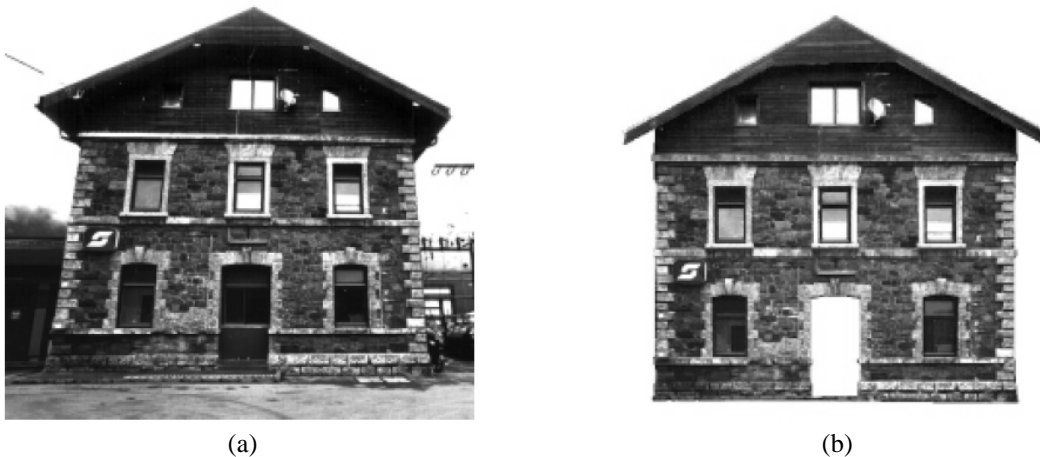
Figura 49 – Experimento realizado em imagem de uma edificação: (a) Foto original; (b) Ortoimagem retificada em escala
