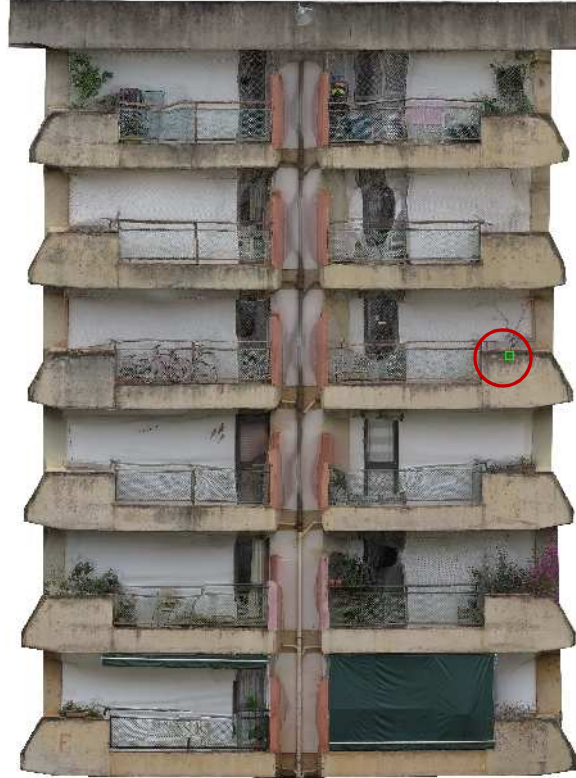
Figura 223 – Ortoimagem e seleção da amostra no edifício B
