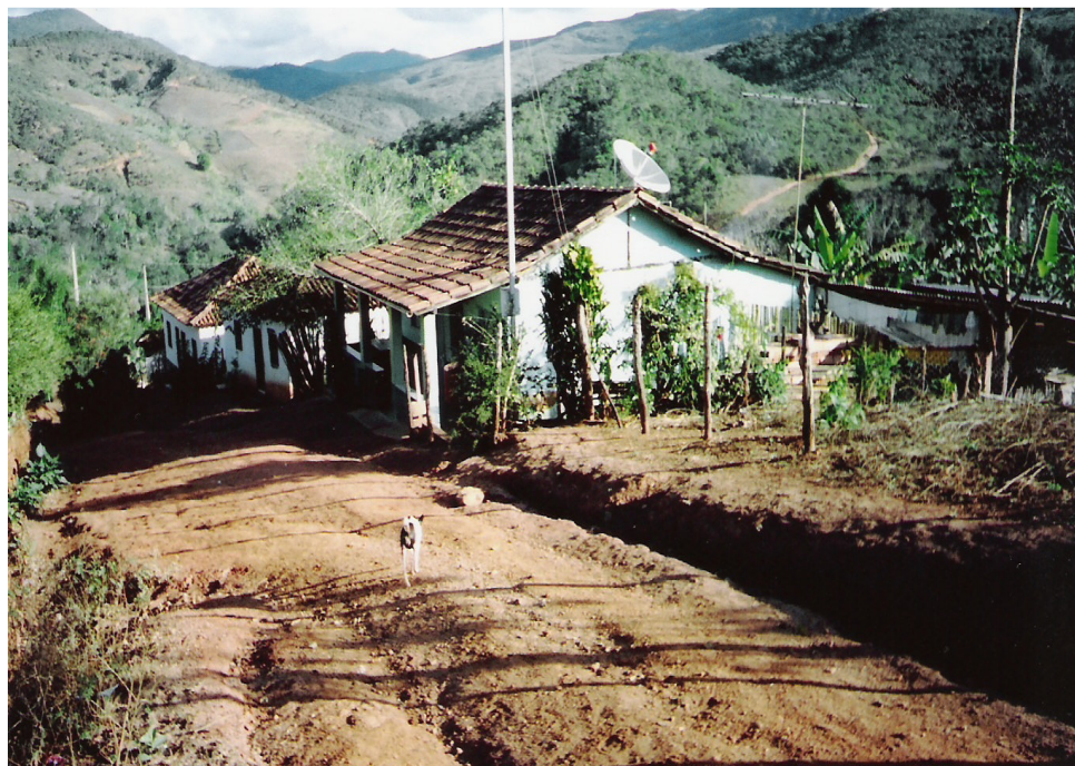
Fig. 4.17: Rua sem calçamento, sem calçada para pedestre, apresentando processos erosivos devidos ao escoamento de águas pluviais em solo de grande declividade. (2005)
