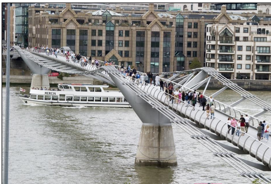
Figura 2.14 – Passarela do Millenium, Londres – Inglaterra
