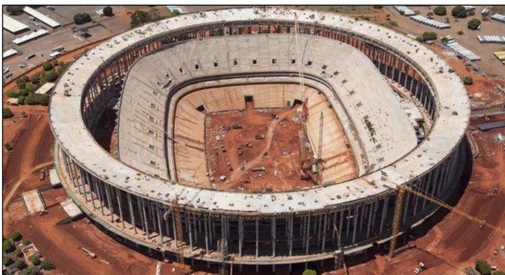
Figura 6.4 – Cobertura do Estádio Nacional de Brasília em construção – Lima (2013)
