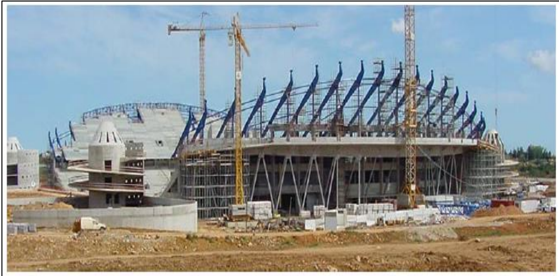
Figura 2.9 – Estádio Algarve em construção – Martins et al (2004)
