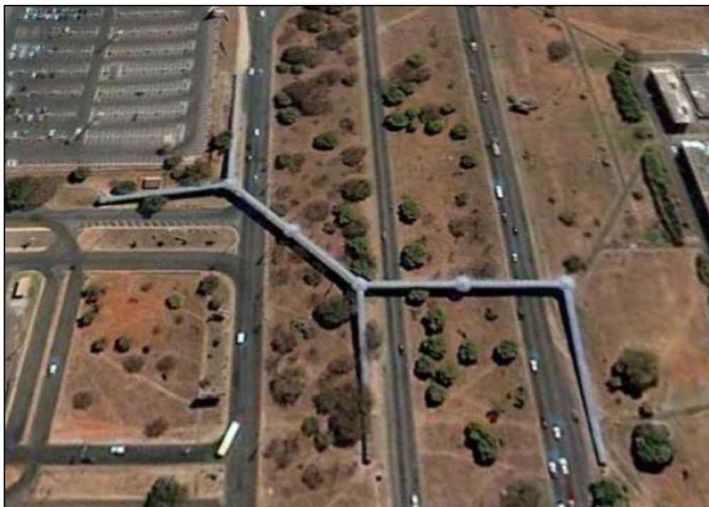
Figura 2.15 – Passarela sobre a E.P.I.A – Gomes (2006)
