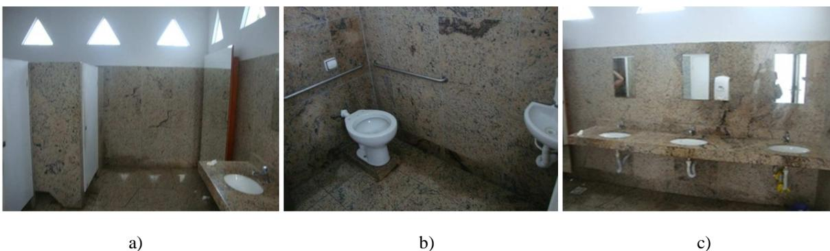
**Ilustração 37** - Banheiro feminino no pavimento térreo do Centro Cultural: a) Espelho adequado para pessoas com cadeira de rodas; b) Sanitário com lavatório; c) Bancada do lavatório do banheiro
