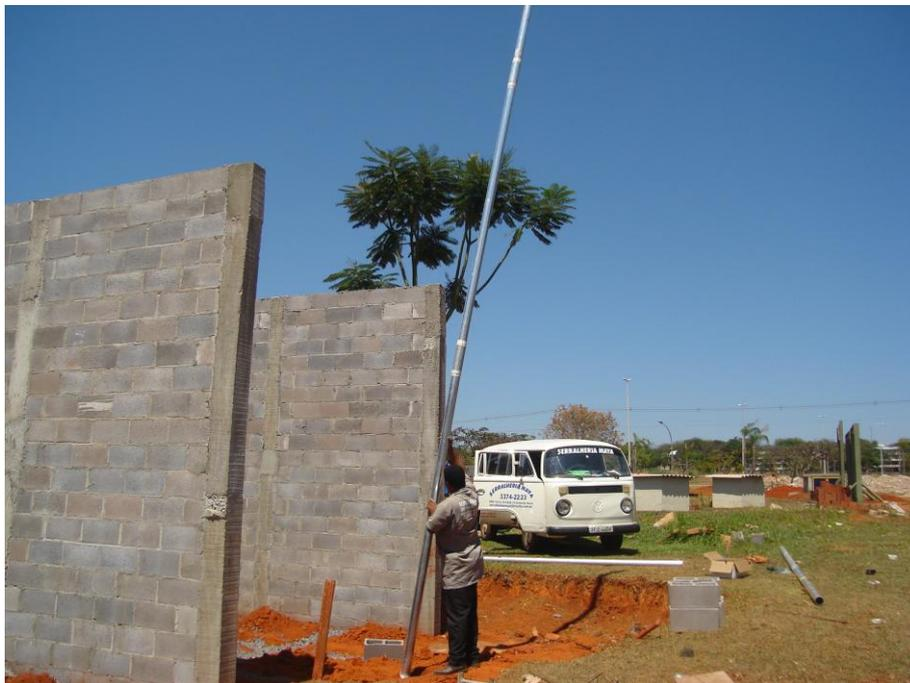
Figura 3.22. Instalação do tubo de inclinômetro.
