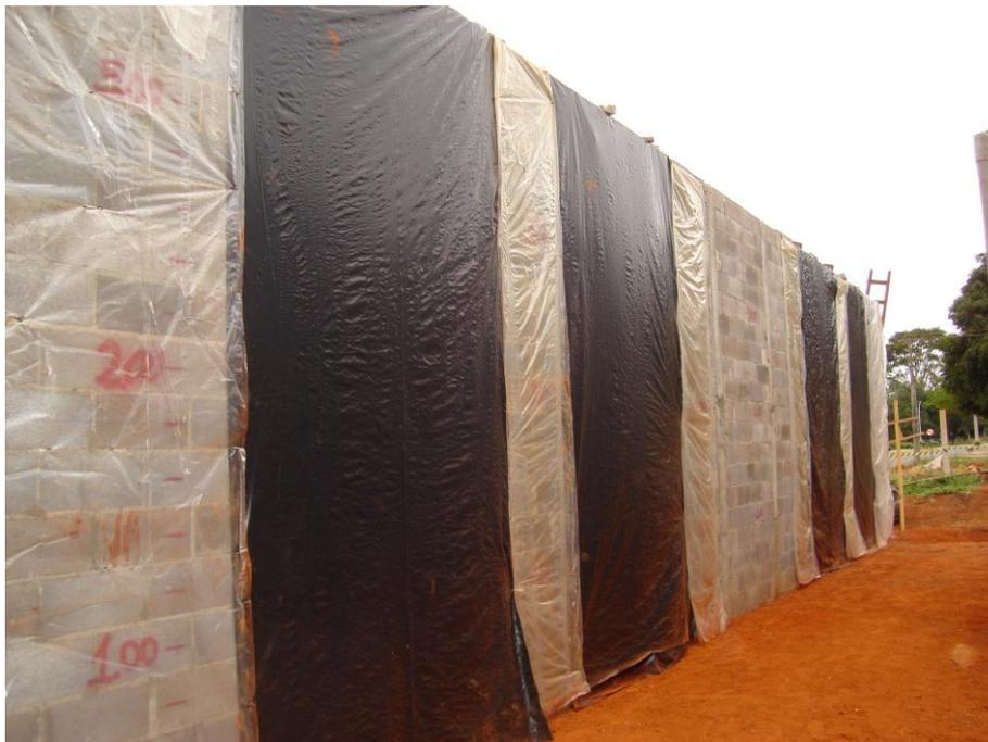
Figura 3.46. Paredes internas revestidas com lonas lubrificadas.
