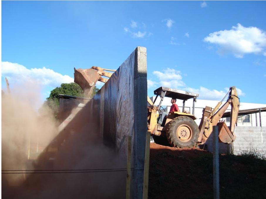
Figura 3.49. Lançamento do RCD-R durante a construção dos muros experimentais.
