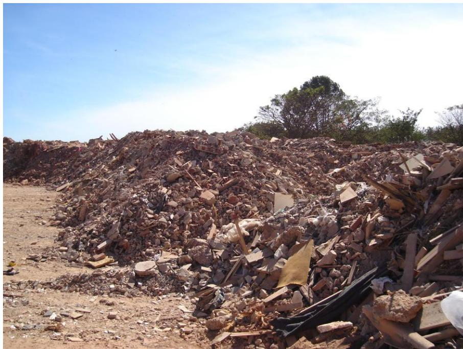
Figura 3.1. Pátio de estocagem de RCD, na UREB.
