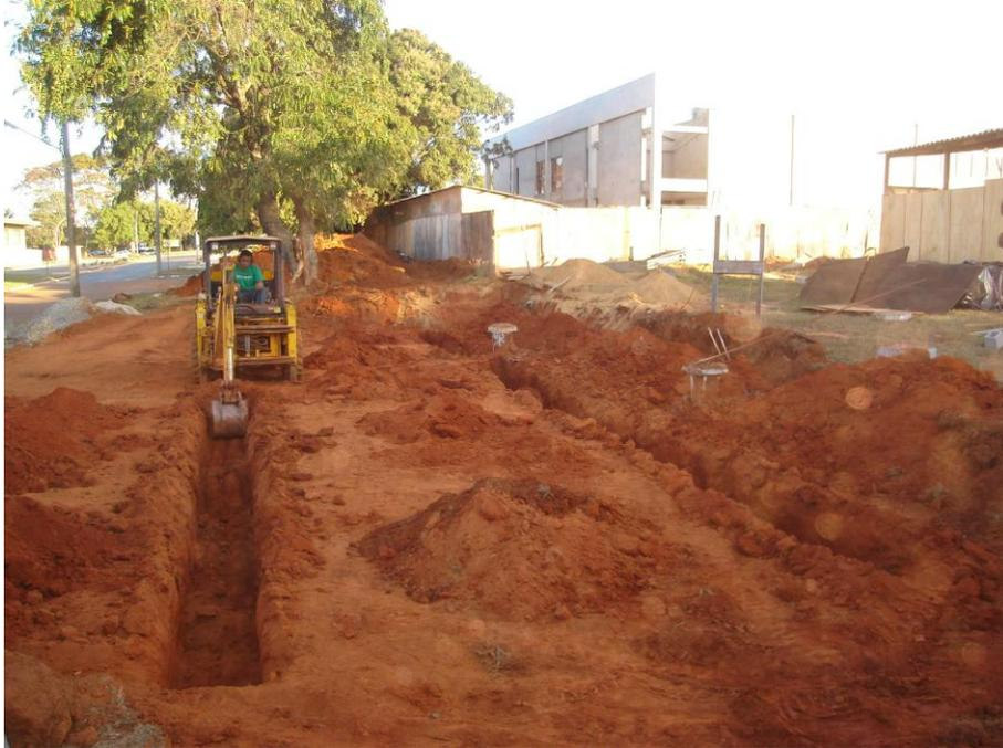
Figura 3.44. Escavação da fundação dos muros laterais de bloco de concreto.
