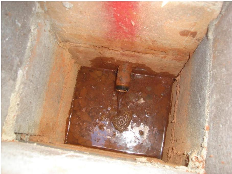
Figura 3.20. Poço de inspeção do sistema para a inundação.
