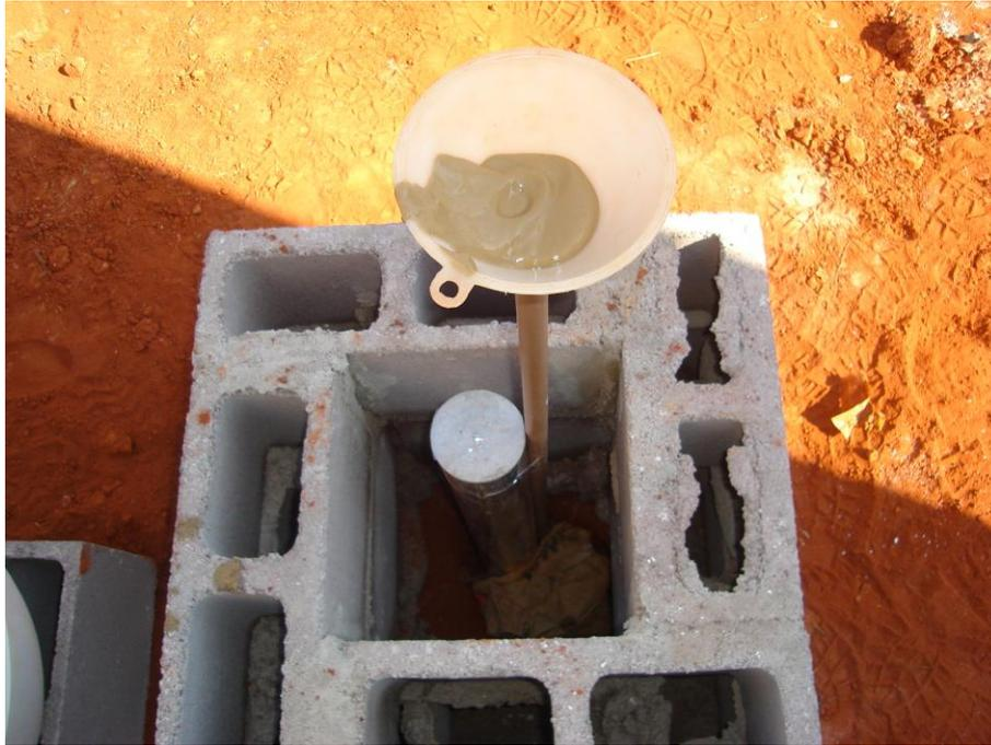
Figura 3.23. Preenchimento do espaço entre o furo a trado e a superfície externa do tubo de inclinômetro.
