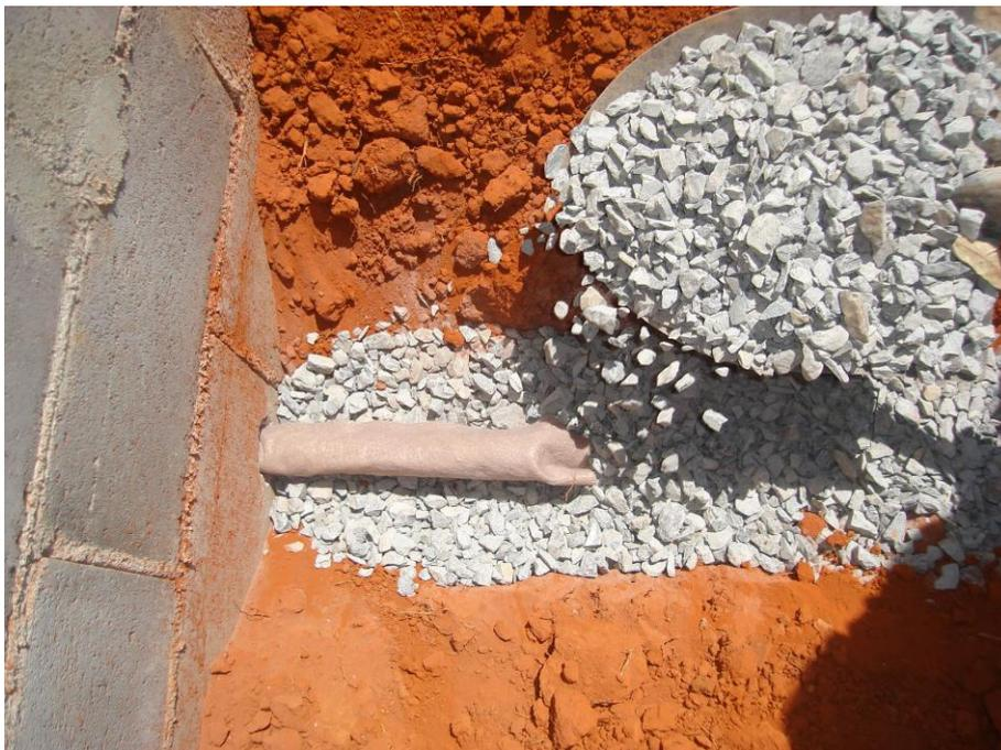
Figura 3.14. Instalação de um dos tubos de verificação.
