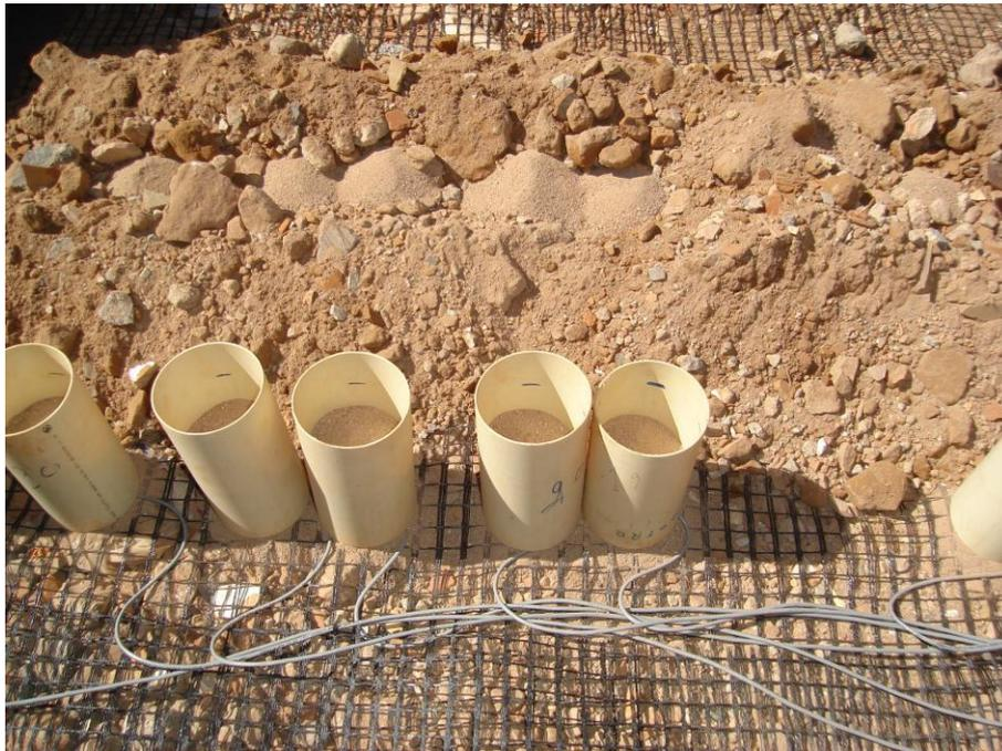
Figura 3.31. Espalhamento do RCD-R ao redor dos tubos de PVC.
