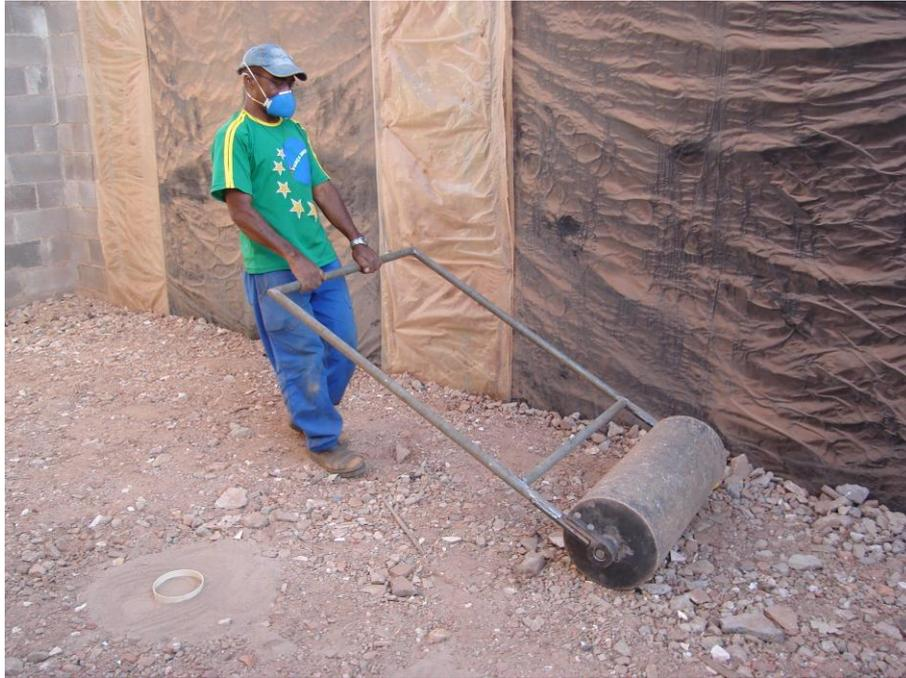
Figura 3.50. Compactação e regularização da camada de RCD-R, durante a construção dos muros experimentais (Muro 1 e 2).
