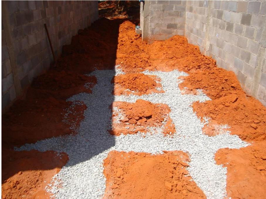
Figura 3.15. Drenos de brita do sistema de inundação.
