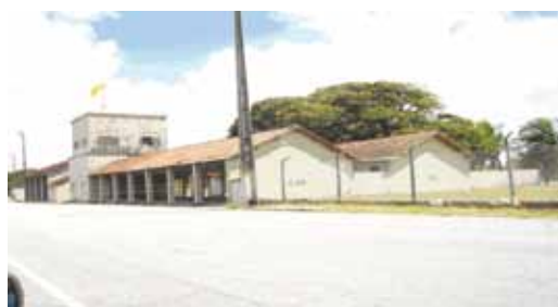
Ilustração 3 – Edificações de oficinas e garagens
