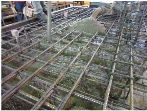
c) Concretagem das lajes
