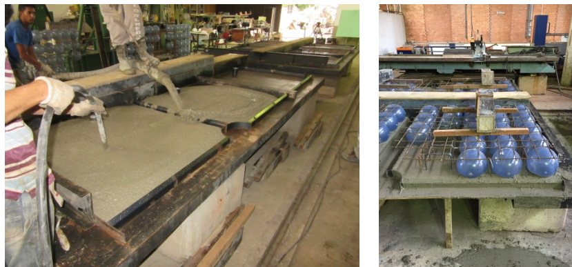
Figura 3.25 – Concretagem das pré-lajes
