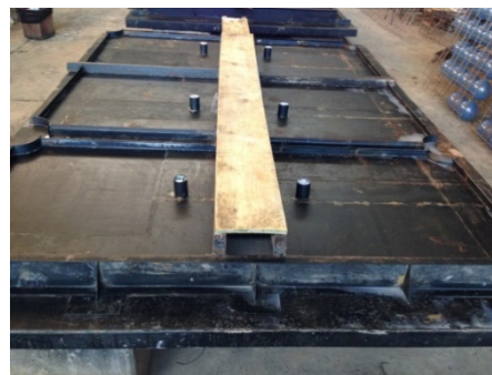
b) Formas metálicas das pré-lajes
