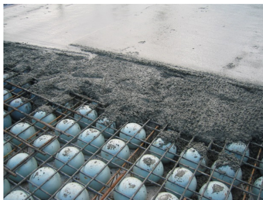
Figura 2.14 – Concretagem final da laje. [ http://www.bubbledeck.com.br ]
