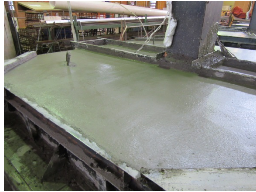
d) Acabamento das lajes
