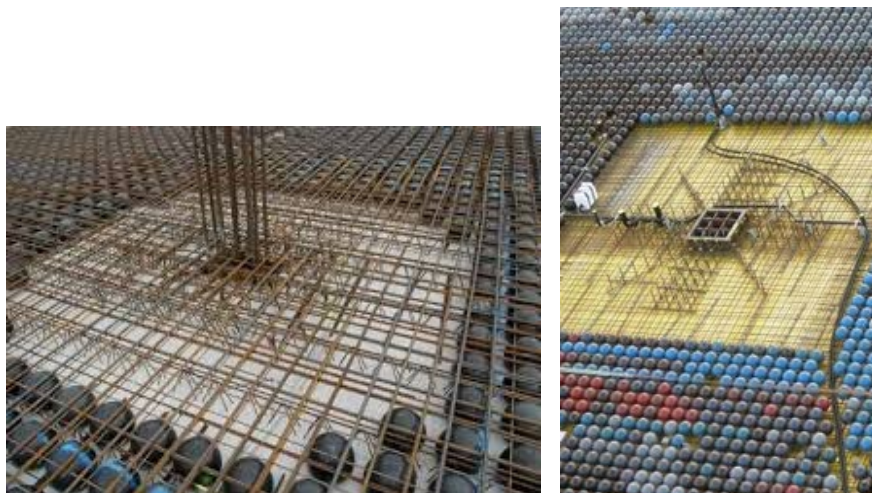
Figura 2.13 – Colocação das armaduras. [ http://www.bubbledeck.com.br ]
