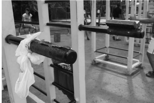
Figura 9: Circuito para ginástica instalado com sinais de desgaste.
