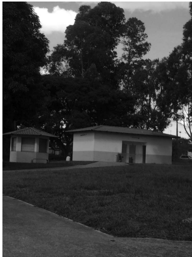
Figura 17: Quiosque em desuso, conjunto de banheiros
