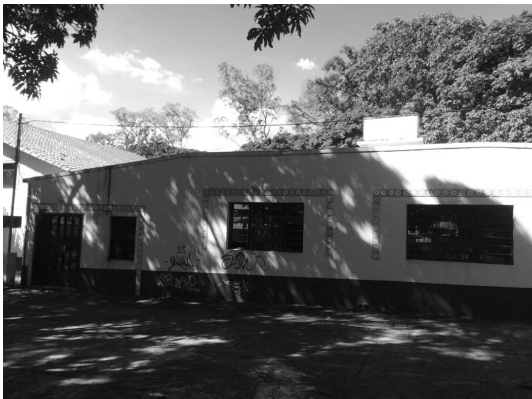
Figura 19: Casarão histórico depredado, com janelas quebradas.
