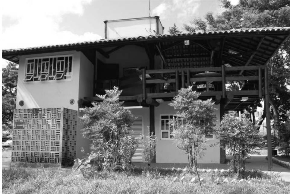
Figura 3: Sede do Parque Ecológico dos Jequitibás, instalada com recursos de compensação ambiental.
