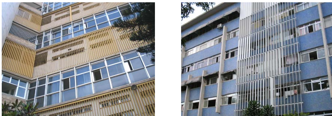
Figura 4.10: Exemplos de brises com função de resguardar a área de serviço (SQS 203, bl. G e SQN 315, bl. I).
