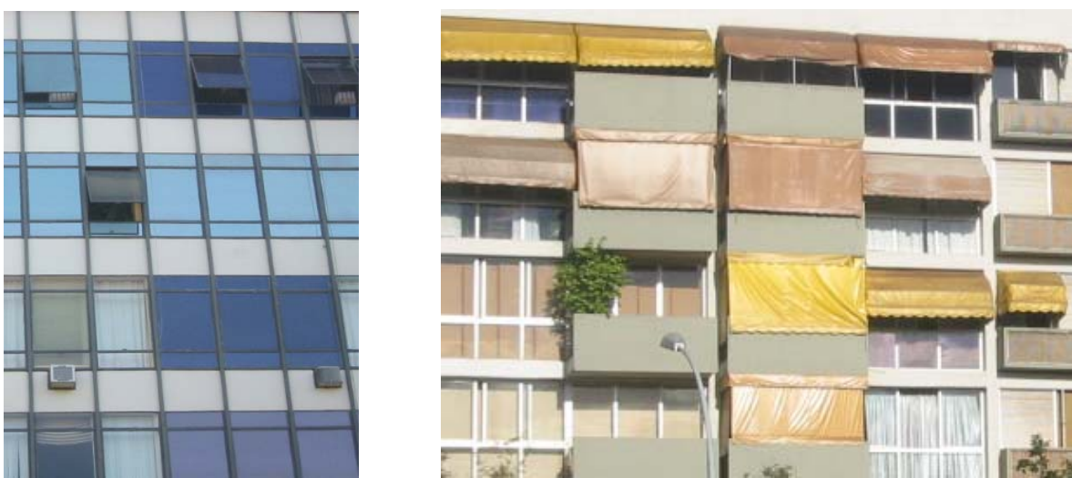
Figura 4.12: Exemplos de películas, toldos e caixas de ar condicionado nas fachadas.
