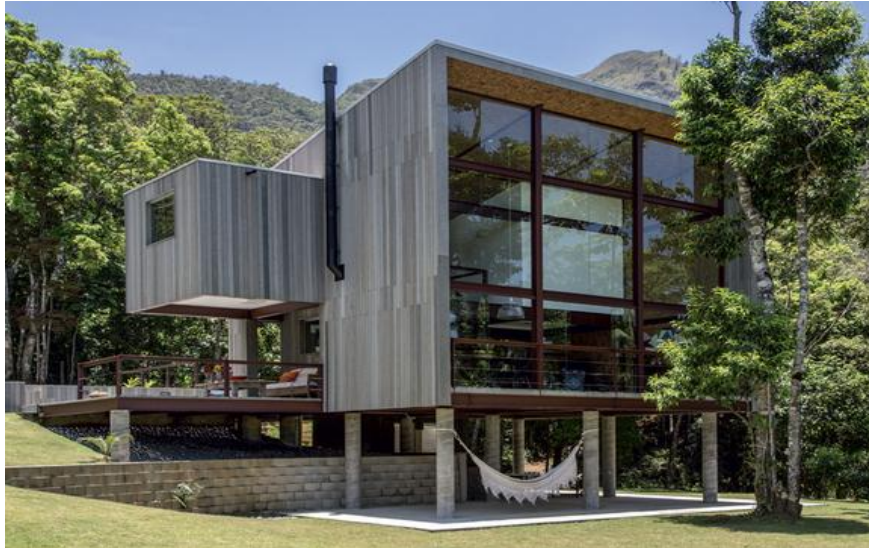
Figura 1.14 – Uso da madeira plástica em fachadas. Projeto de Tatiana Terry e Luciano Alvarez. Residência localizada na Serra Fluminense.
