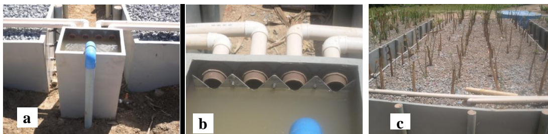
FIGURA 4. Caixa de passagem para os leitos cultivados (a), vertedouros triangular no interior da caixa de passagem (b) vista dos leitos cultivados com plantas recém-transplantadas e do leito não cultivado (c).
