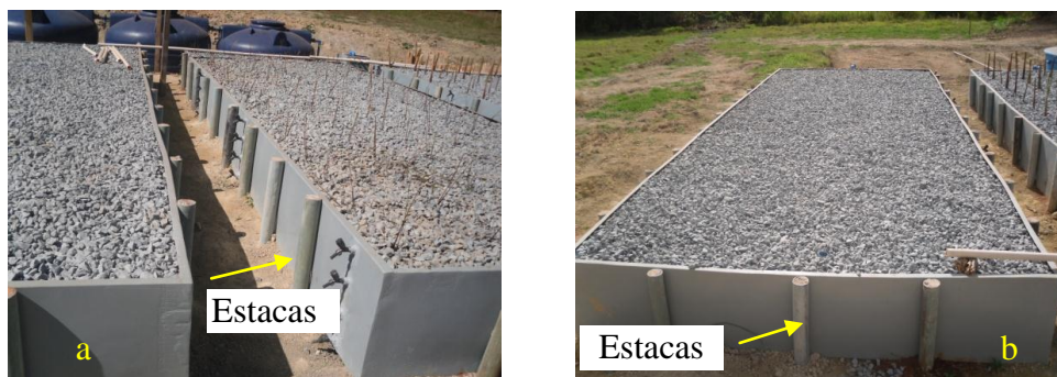
FIGURA 7. Estacas de sustentação dos leitos cultivados no sentido do comprimento (a) e no sentido da largura (b).
