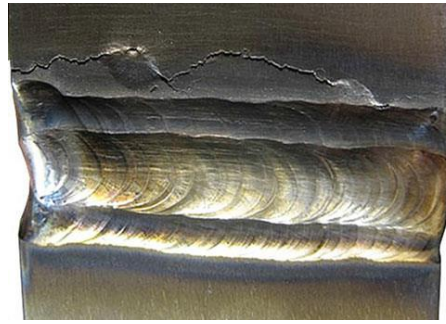
Figura 2.6. Falha na reparação da trinca após soldagem, devido à formação de novas trincas durante o resfriamento da solda [35]
