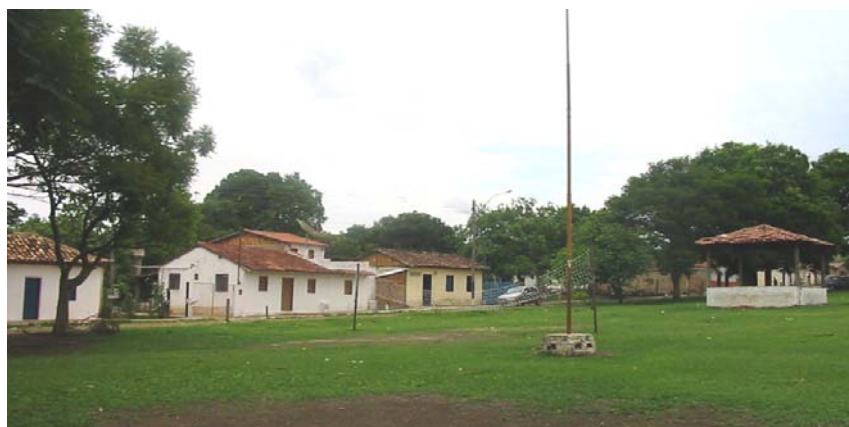
Fig. 24 - Vista da praça central de Olhos D'água. Fonte: Plano Diretor de Alexânia.
