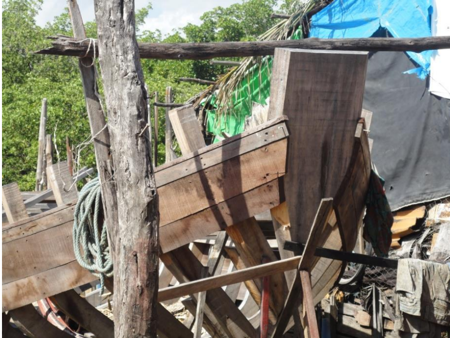
Figura 7 - No detalhe, a estrutura de uma canoa em um estaleiro de beirada em Raposa/MA. 2013.
