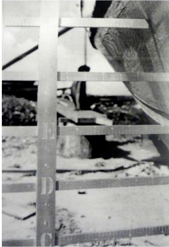
Figura 19 - No detalhe, o cavernômetro em ação. Caderno 1 - São Luís, 1986.
