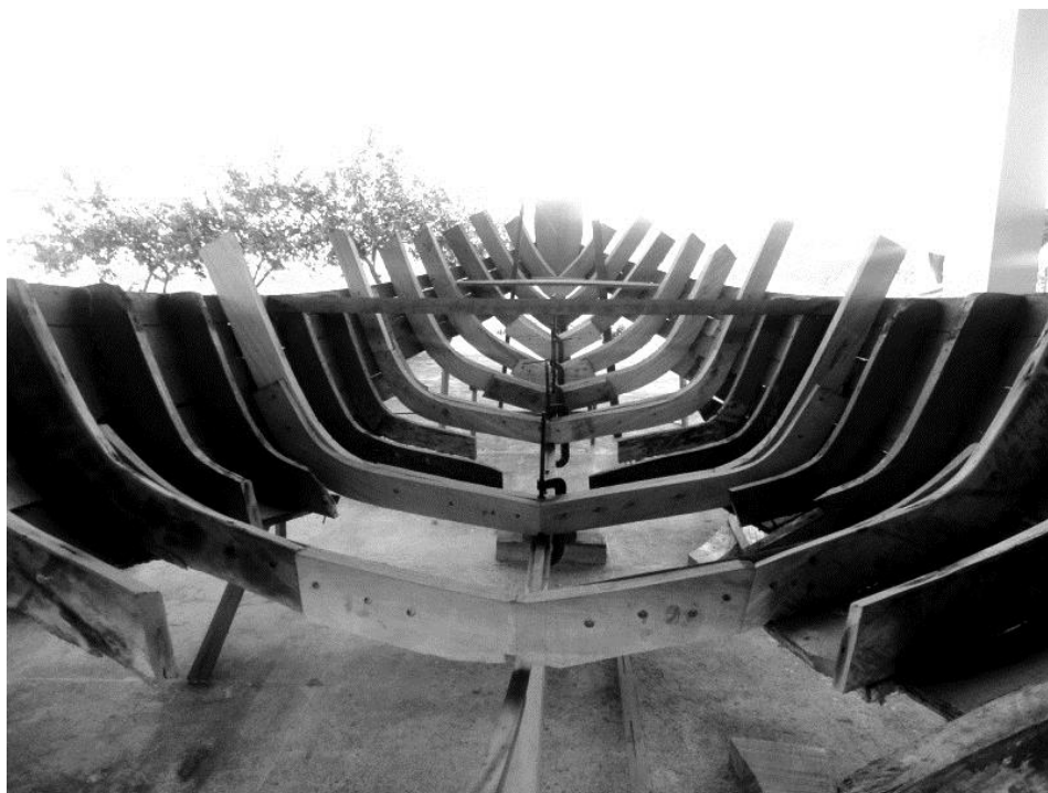
Figura 32 - Detalhe das cavernas da biana em construção. Peças básicas da estrutura de uma embarcação
