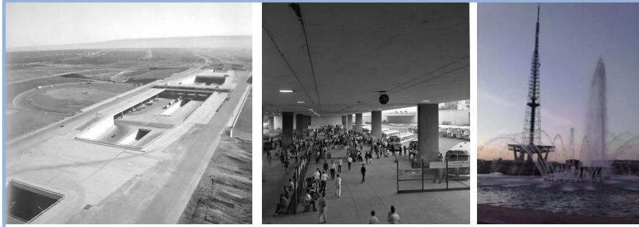
Figura 29: Eixo monumental - Construção da Rodoviária (1957) piso inferior (1960) Torre de TV- Brasília - DF Fonte: Arquivo Público Nacional , 2013.
