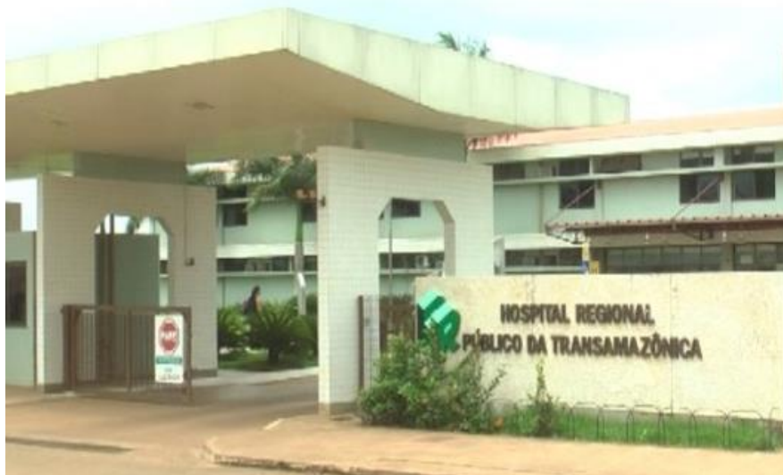
Figura 54 – Hospital Regional Público da Transamazônica de Altamira Fonte: por Missifany Silveira, 2015.
