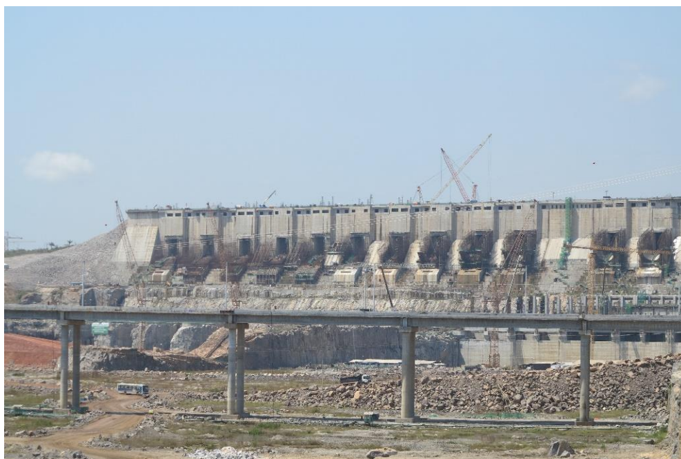
Figura 23 – Vista da UHE de Belo Monte
