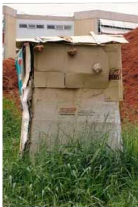
Fig. 26 - Uma forma de construção de banheiro. Foto: Anelise W. Ferreira. Ano: 2006
