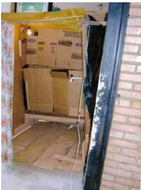
Fig.64 - Interior da "Estrutura parasitária", construída com tabuas de madeira, papelão e uma "gambiarra" para água e luz. Foto: Anelise W. Ferreira. Ano: 2006.
