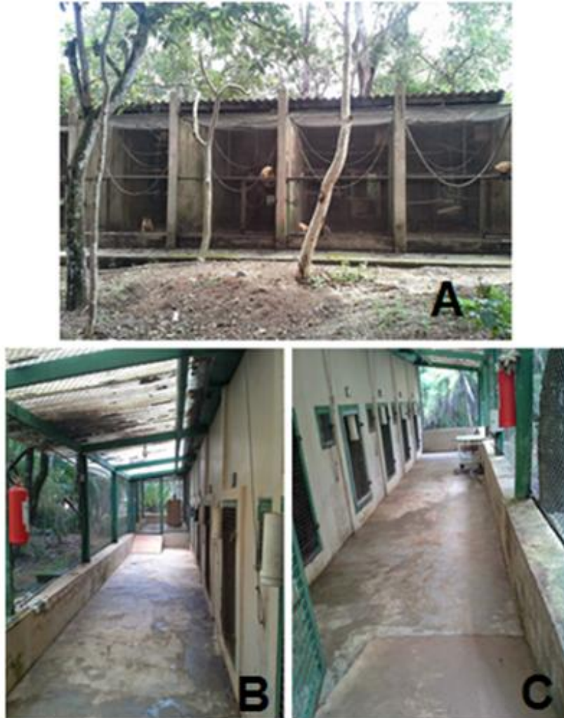
Figura 4. Pavilhão Central dos Sapajus spp. (A) Vista frontal dos viveiros. (B e C) Vista da área de manutenção dos viveiros. Fotos: Mariana Jacobsen
