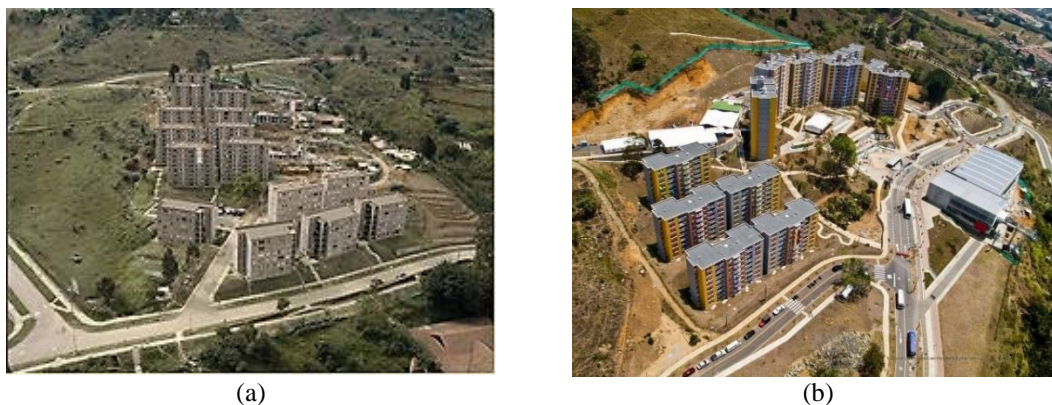
Figura 5.7 – Processo de construção Ciudadela Nuevo Occidente. Fonte: Ministério de habitação. 2010
