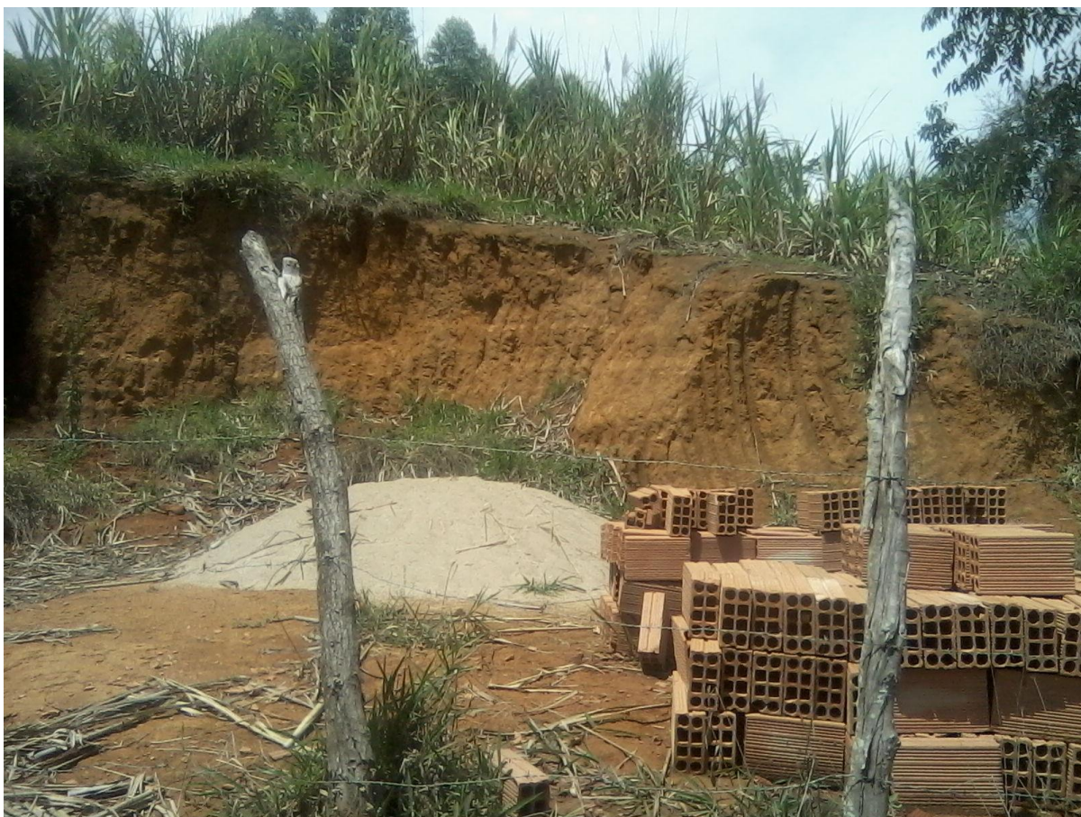
Figura 28: Local onde será construída a casa da filha do senhor Adão, no interior do seu lote do assentamento PA Cafundão. Acervo de pesquisa (2014).
