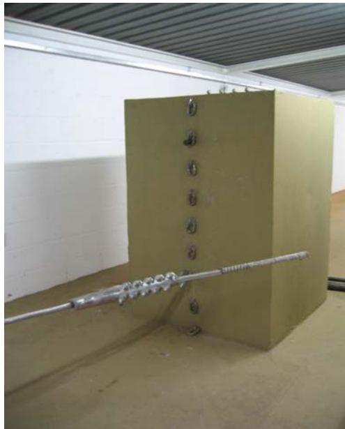
Figura 5.8 – Detalhe mostrando o cabo preso ao grampo de fixação e ao bloco de ancoragem.
