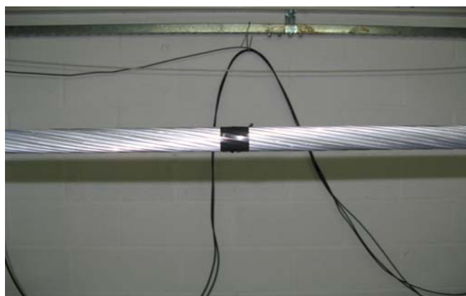
Figura 7.13 – Marcação do nó onde será instalado o dispositivo de detecção de quebra de fios.
