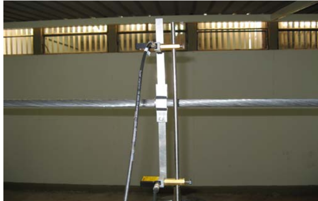
Figura 7.14 – Instalação do dispositivo de detecção de quebra de fios.
