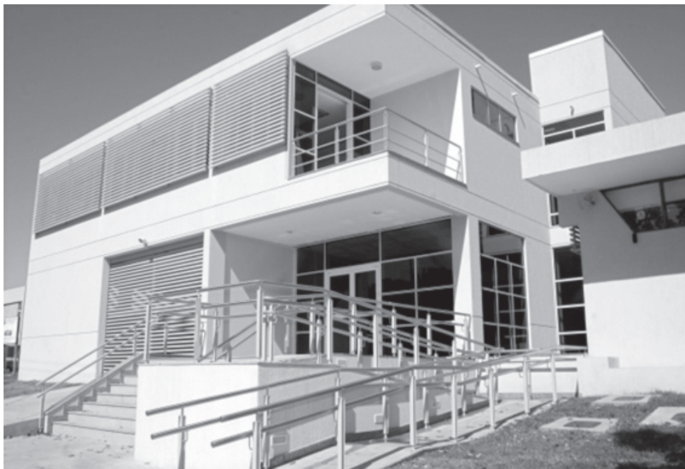
Figura 131b. Vista da Fachada Oeste
