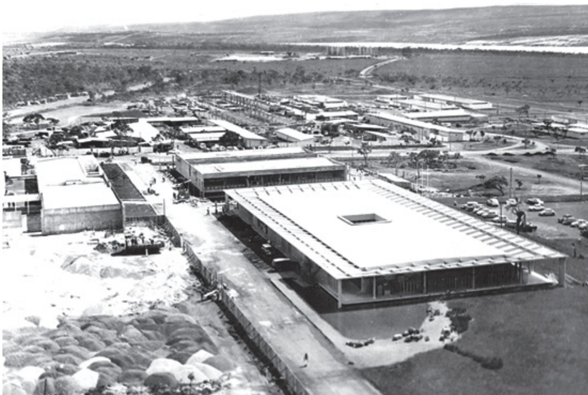
Figura 53b. Vista aérea das obras da Faculdade de Educação, com a FE 1 no primeiro plano
