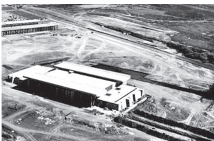
Figura 99b. Vista aérea da Biblioteca Central em obras
