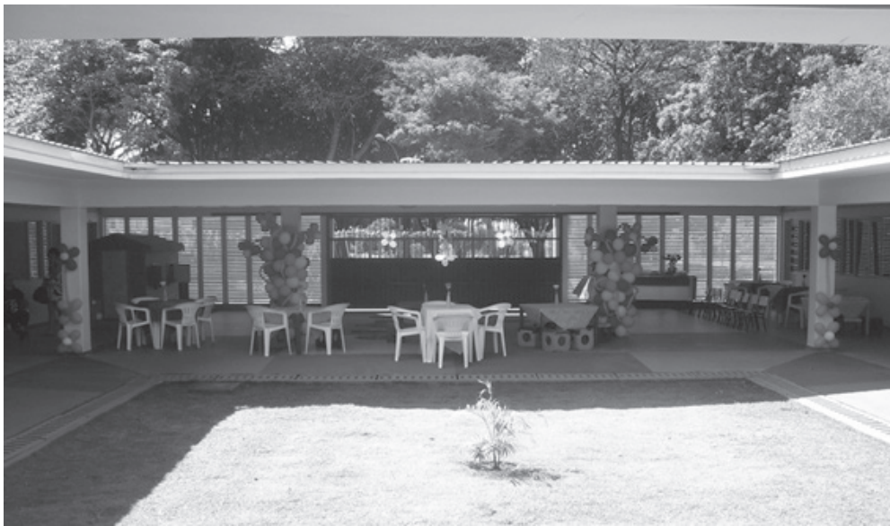
Figura 159f. Vista do acesso
