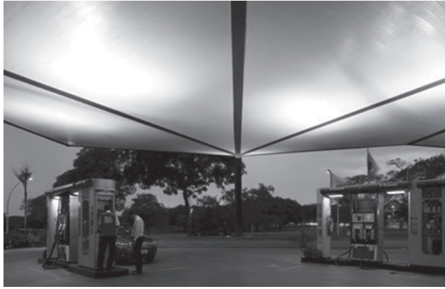
Figura 134d. Vista das bombas de abastecimento
