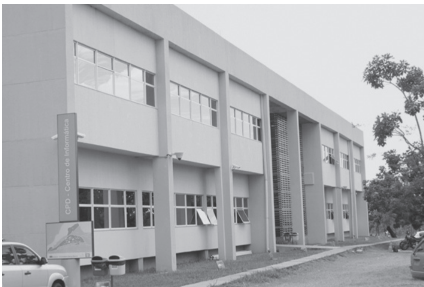
Figura 165b. Detalhe dos brises.
