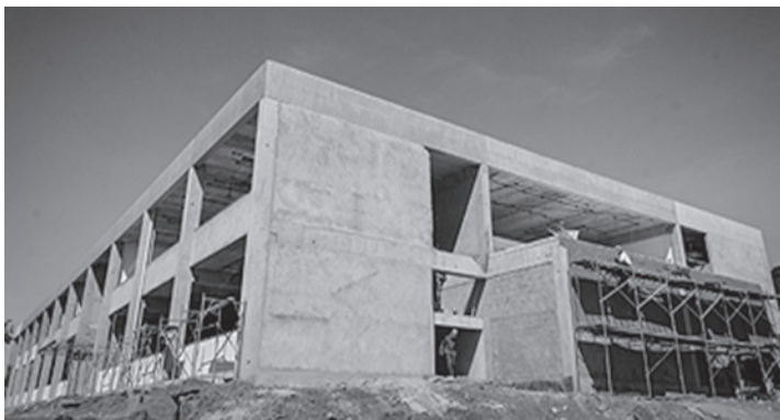
Figuras 168b. Vista da fachada Oeste
