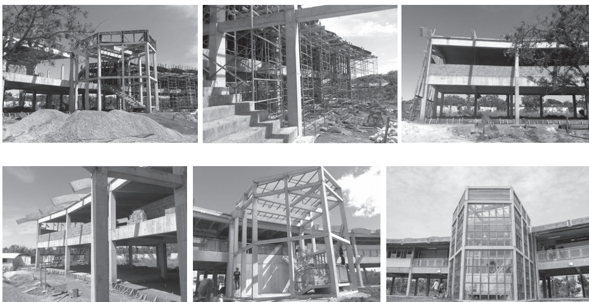
Figuras 170c, d, e, f e g. Registros da obra
