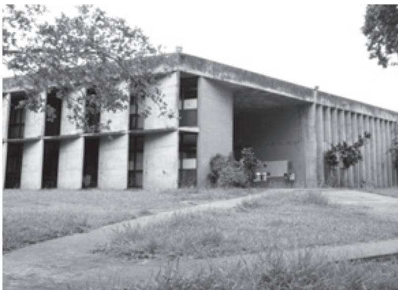
Figura 109d. Vista do pátio interno com a passarela metálica
