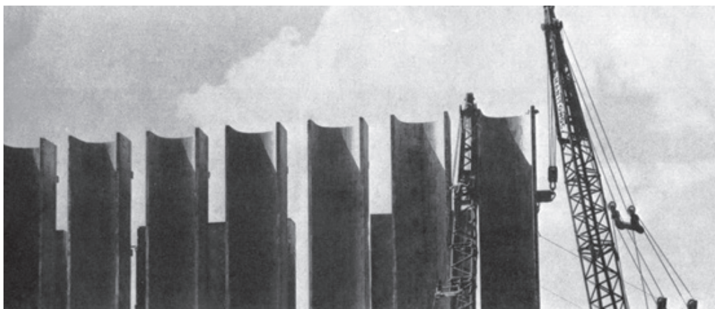
Figura 46g. Montagem das colunas-parede
