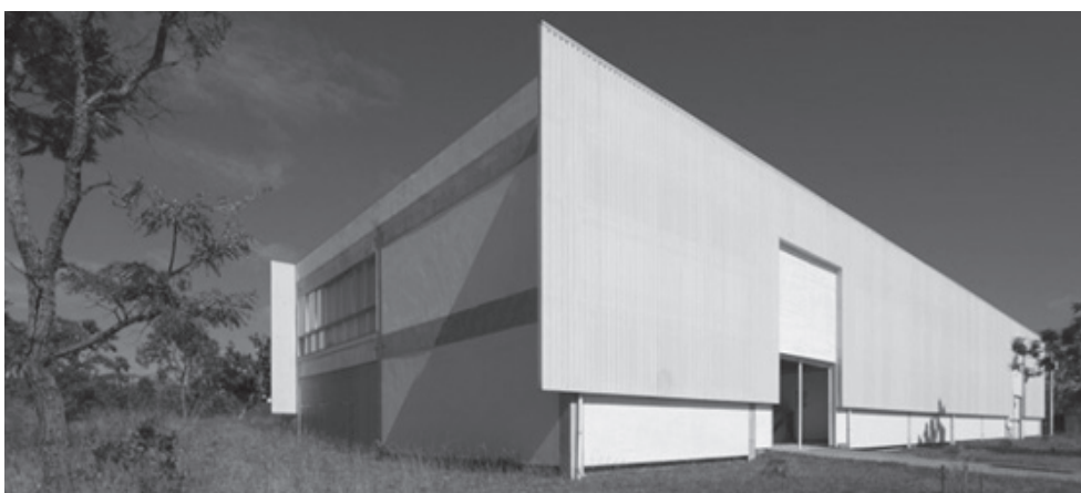
Figura 161b. Vista da fachada principal.
