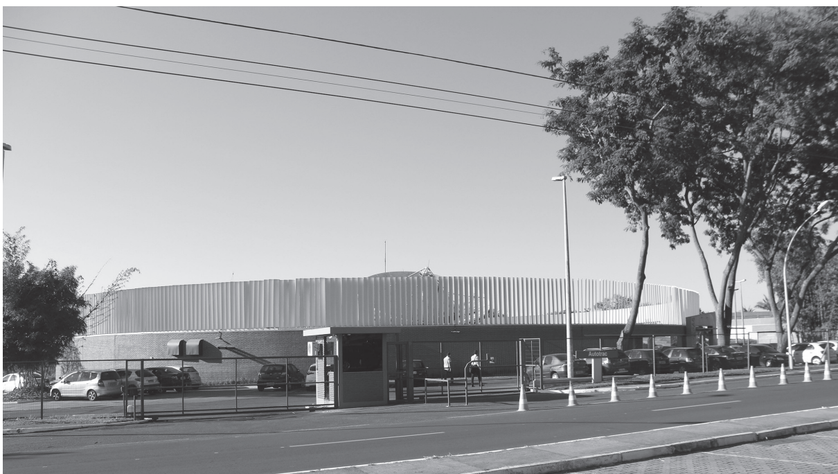
Figura 130d. Fachada principal. Foto Silvio Cavalcante
