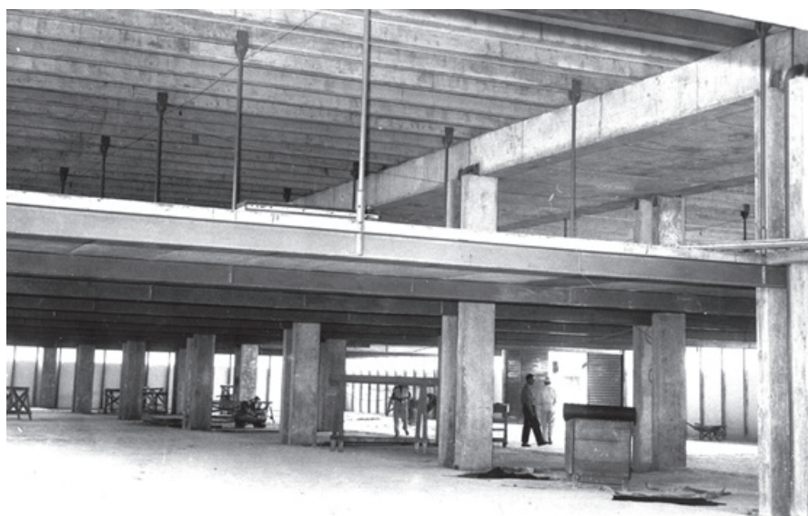
Figura 56h. SG 12: Montagem do mezanino
