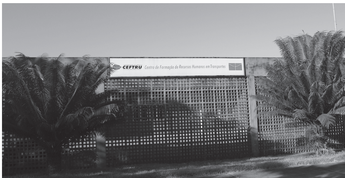
Figura 132c. Vista da fachada Leste
