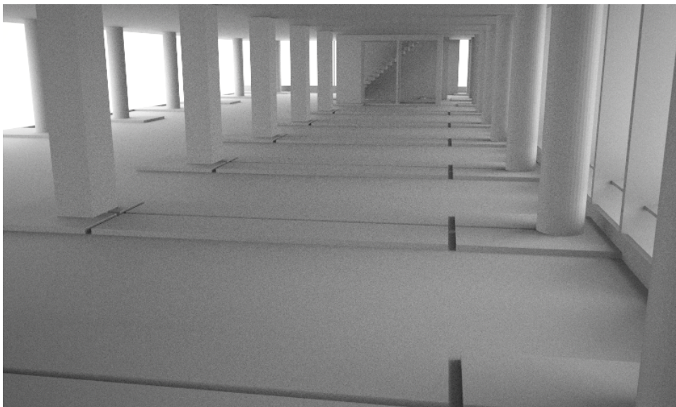
Figura 304 – Interior do pavimento tipo: pano de laje liso na parte inferior e com capitéis no piso, o espaço vazio ficou destinado para as instalações elétricas. Notar a viga correndo na fachada dos brises., Perspectiva estrutural do MESP. Estrutura em concreto armado do MESP conforme projeto estrutural de Emílio H. Baumgart. Fonte: Autor. 2015.
