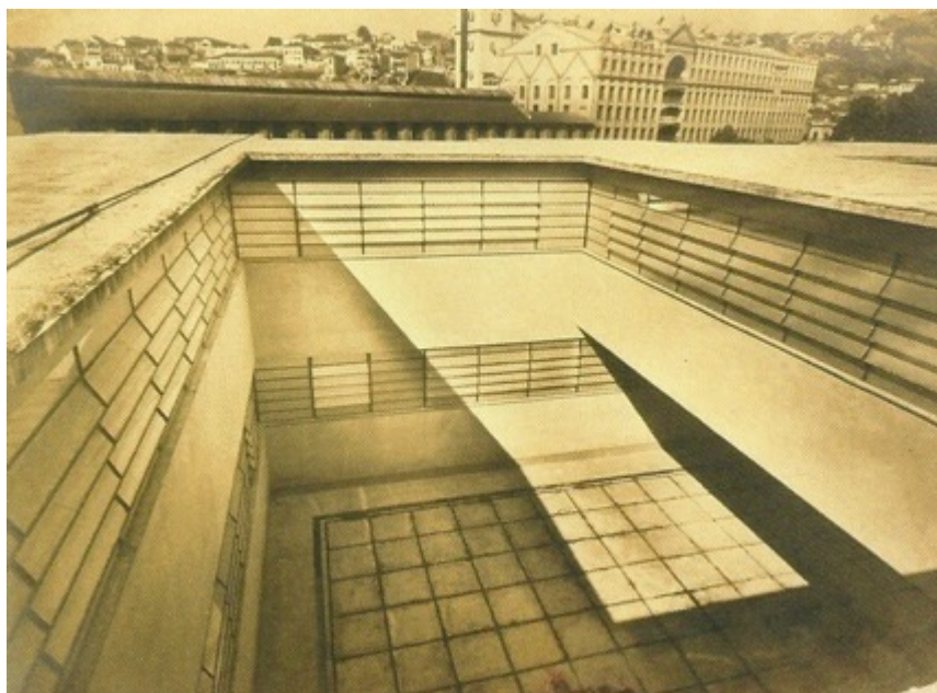
Figura 278 – Vista do pátio, destacando-se as janelas horizontais e uma das primeiras utilizações da laje plana de concreto na arquitetura brasileira. Fonte: Bonduki, 1999.
