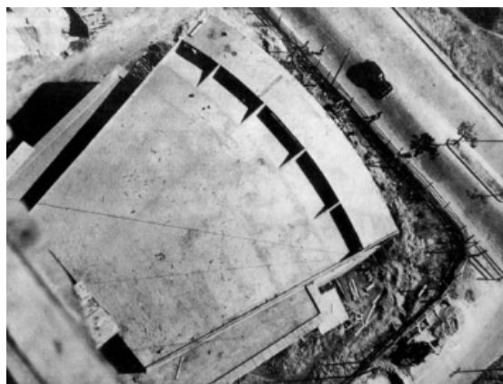
Figura 319 – MESP. Foto da cobertura do salão de conferências (auditório). Fonte: LISSOVSKY, 1996.
