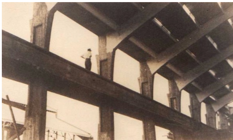
Figura 230 – Detalhe oficina de vagões da E.F.C.B. em Belo Horizonte. FONTE: SEEBLA, 2013.
