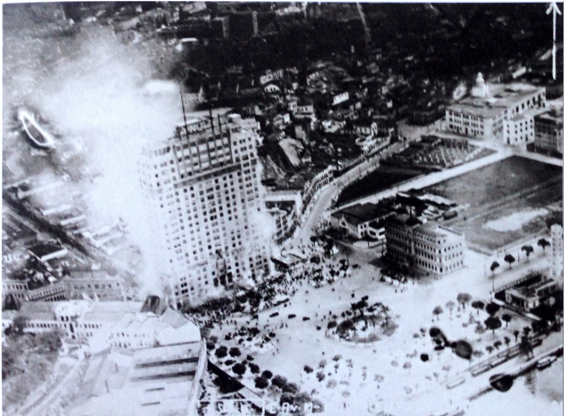
Figura 245 – Foto aérea mostrando o incêndio na redação do Jornal A Noite, após a destruição das instalações do jornal por partidários do presidente Getúlio Vargas durante a revolução de outubro de 1930. A marquise que formava um grande vão livre de proteção da entrada foi demolida e nunca reposta. FONTE: CABOT, 2014.
