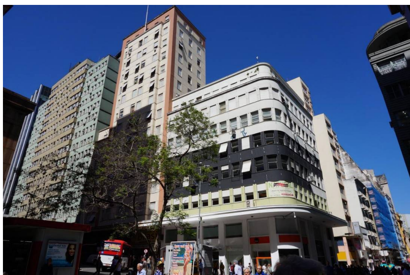
Figura 97 – Edifício Salic ou Sul América. FONTE: Autor, 2014.
