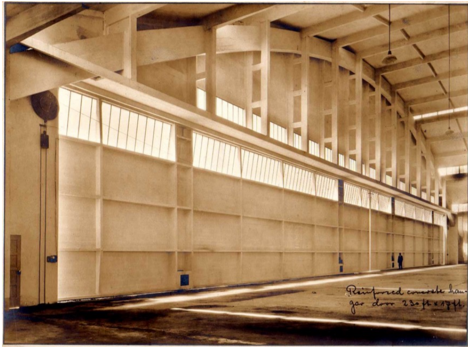
Figura 211 – Interior finalizado mostrando a porta de concreto do hangar. FONTE: SEEBLA, 2013.
