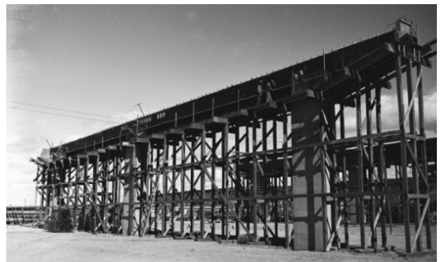
Figuras 157 e 158 – Conjunto de três pilares de um pórtico e etapa posterior com a forma e concretagem de uma viga com 45m de extensão, três apoios e 2m de altura. FONTE: CORULLON, 2013.
