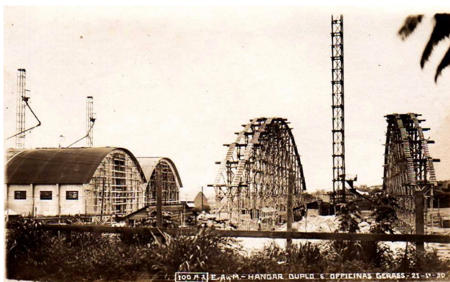
Figura 205 – Etapas de construção: arcos internos. FONTE: SEEBLA, 2013.
