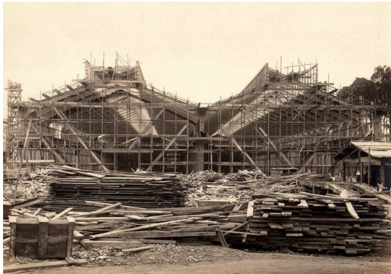
Figura 229 – Etapa de construção da oficina de vagões da E.F.C.B. em Belo Horizonte. FONTE: SEEBLA, 2013.
