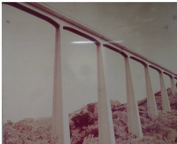
Figura 180 – Viaduto do Funil, Ouro Preto. FONTE: Acervo SEEBLA, 2013.
