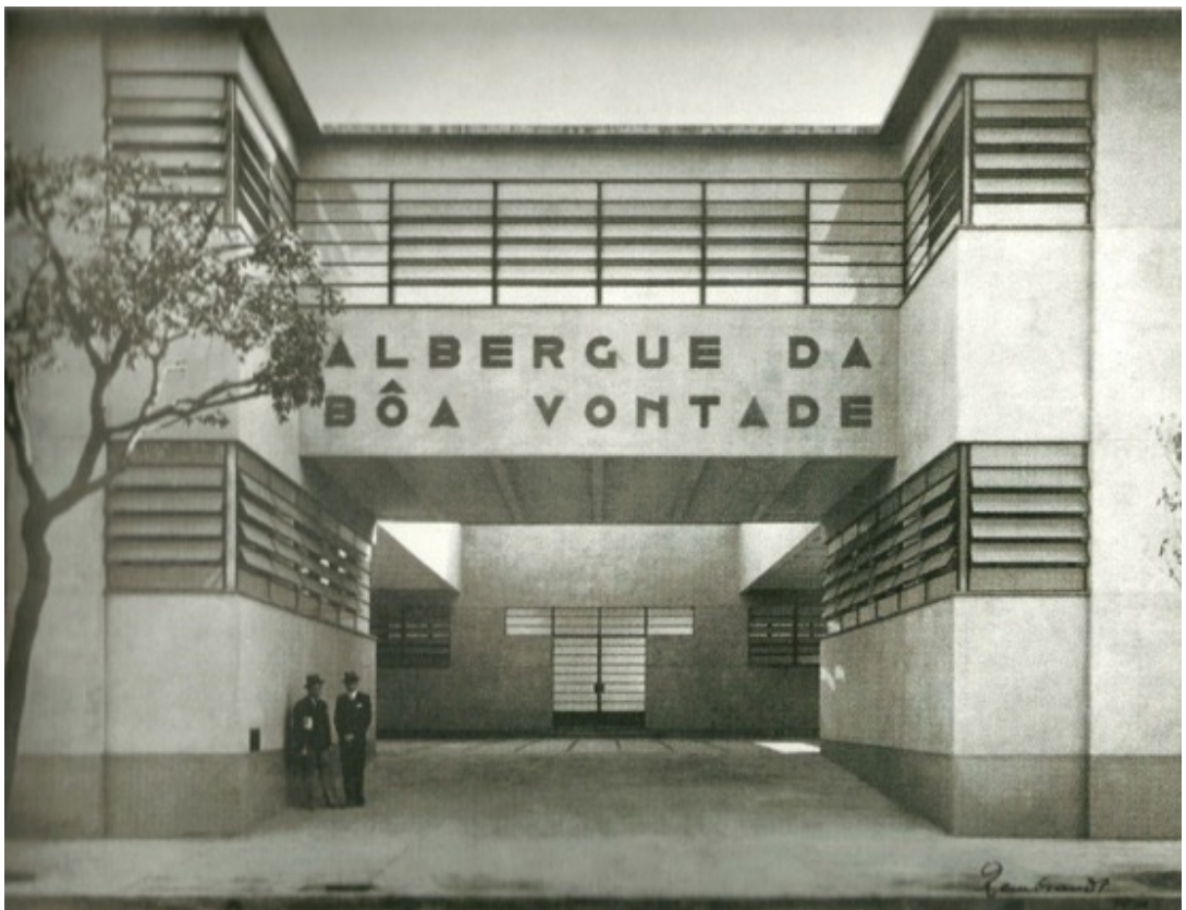
Figura 269 – Foto da entrada principal. Fonte: Bonduki, 1999.
