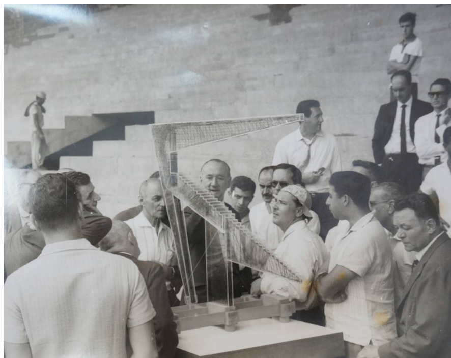
Figura 174 – Prof. Arthur Eugênio Jermann ao centro da imagem atrás da maquete do detalhe da arquibancada do Estádio Magalhães Pinto - Mineirão, Belo Horizonte, 1964. FONTE: Acervo SEEBLA, 2013.
