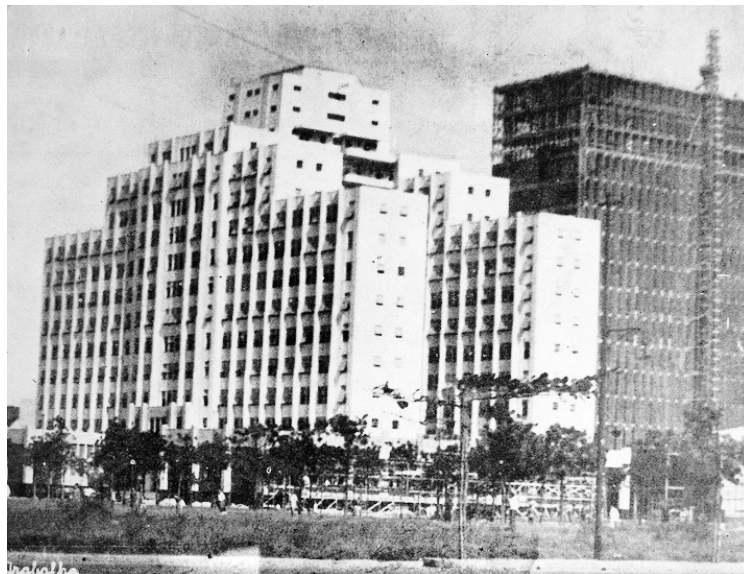
Figura 120 – Vista geral do edifício, ao fundo a construção do MESP. FONTE: CONCRETO, 1938.
