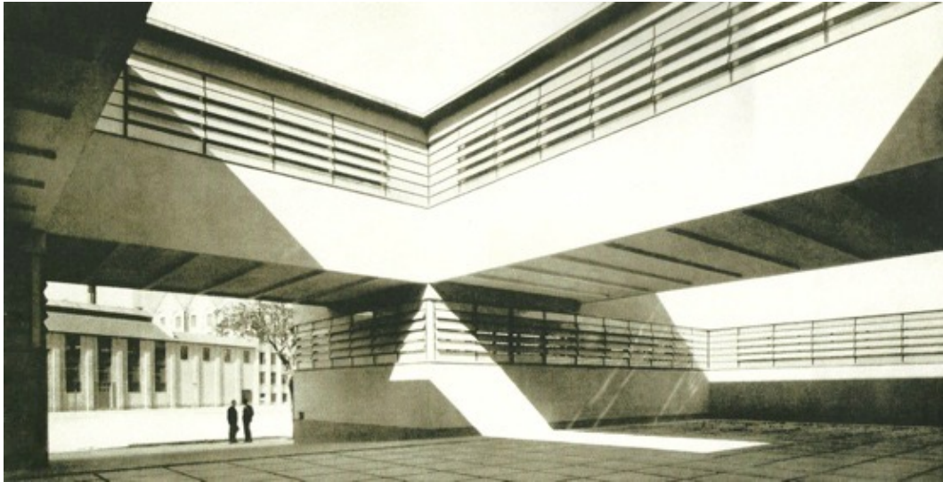
Figura 270 – Acesso principal do albergue mostrando a permeabilidade entre o espaço urbano e o pátio do edifício. Notar a ausência de pilares de sustentação do pavimento superior e o jogo estrutural de vigas e pilares de transição sobre as vigas. Fonte: Bonduki, 1999.
