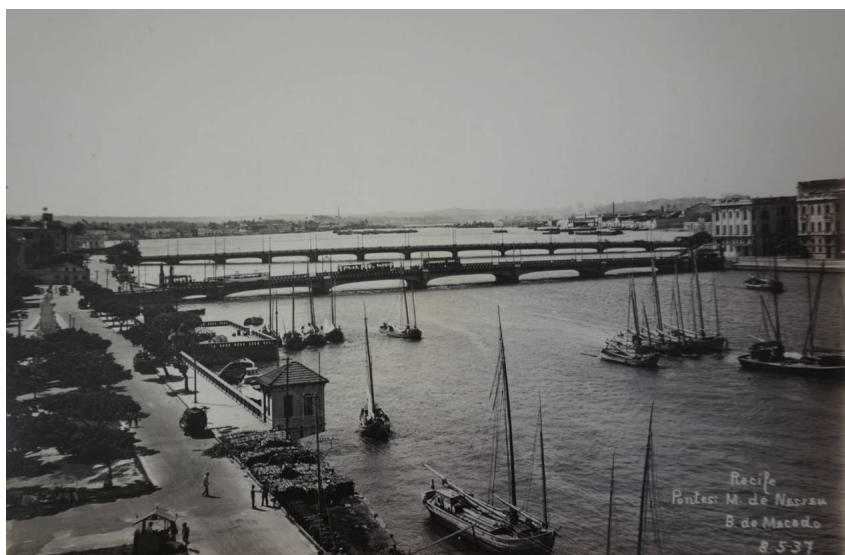
Figura 51 – Foto da Ponte Maurício de Nassau. FONTE: Acervo de documentos SEEBLA – Serviços de Engenharia Emílio Baumgart Ltda.; Belo Horizonte, 2013.
