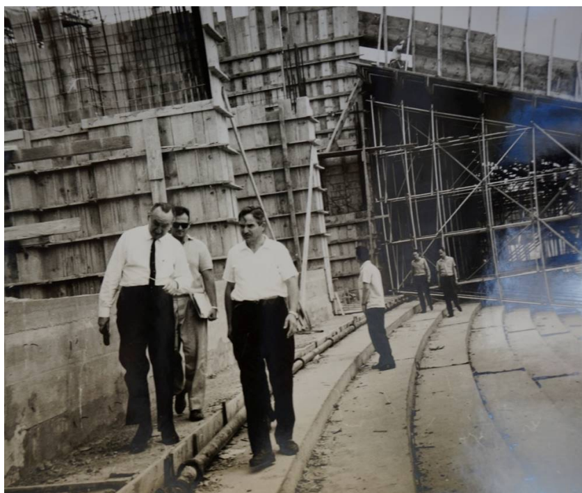
Figura 177 – Prof. Arthur Eugênio Jermann na obra do Estádio Magalhães Pinto - Mineirão, Belo Horizonte, 1964. FONTE: Acervo SEEBLA, 2013.
