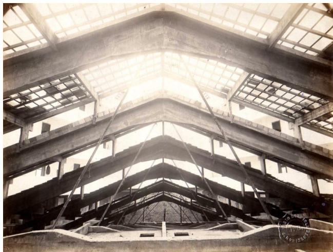
Figura 361 – Cine Brasil. Tesouras de concreto da cobertura. Fonte: SEEBLA, 2013.
