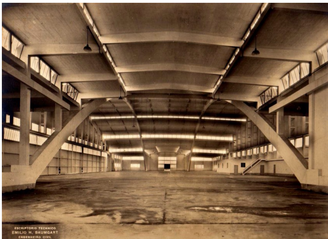
Figura 210 – Interior finalizado. FONTE: SEEBLA, 2013.
