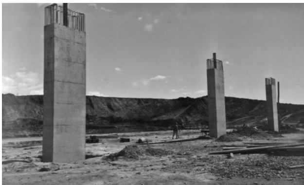
Figuras 157 e 158 – Conjunto de três pilares de um pórtico e etapa posterior com a forma e concretagem de uma viga com 45m de extensão, três apoios e 2m de altura. FONTE: CORULLON, 2013.
