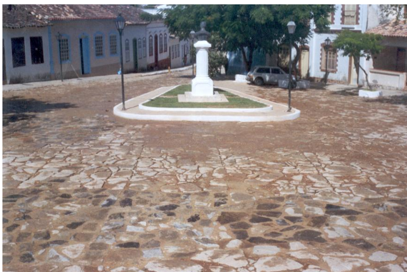
Largo do Rosário depois de concluída a obra de calceteria Foto: Izabela Tamasso (2002)
