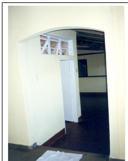
Esquadria do banheiro voltada para o corredor interno. Ao fundo, cozinha.
