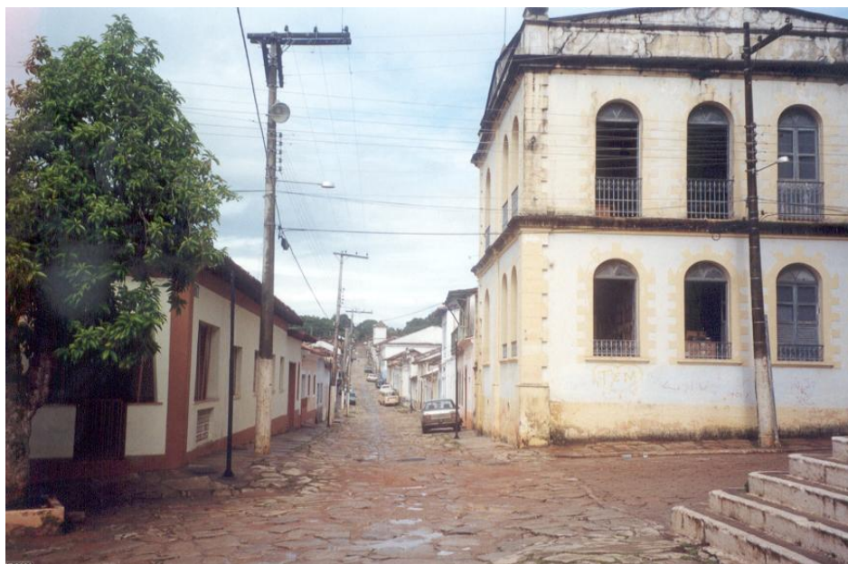
Rua Senador Eugênio Jardim – Postes e fiação aérea Foto: Izabela Tamasso (2001)
