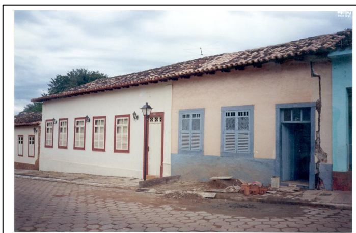
Casa à Rua Monsenhor Azevedo – Ao lado da porta vê-se fissura para instalação do tubo de fiação
