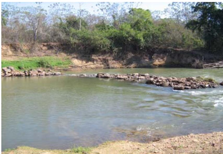
Figura 18 – Barramento precário no local de captação do PCPER I no ribeirão Entre-Ribeiros.
