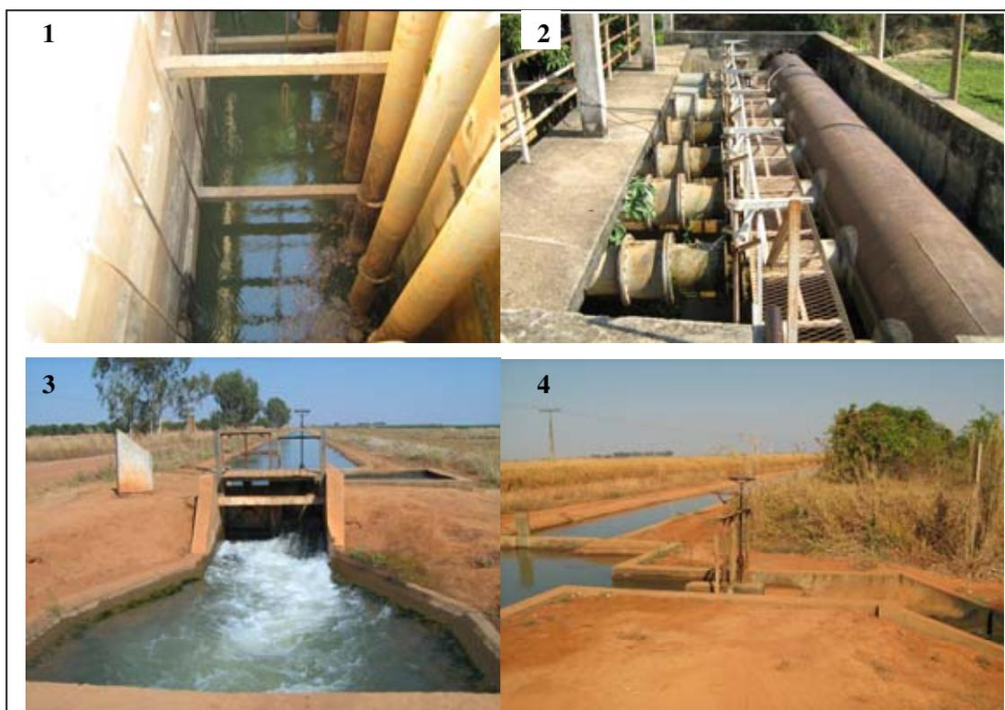
Figura 20 – Estação de captação e bombeamento e canais de distribuição de água do projeto de irrigação do PCPER I.
