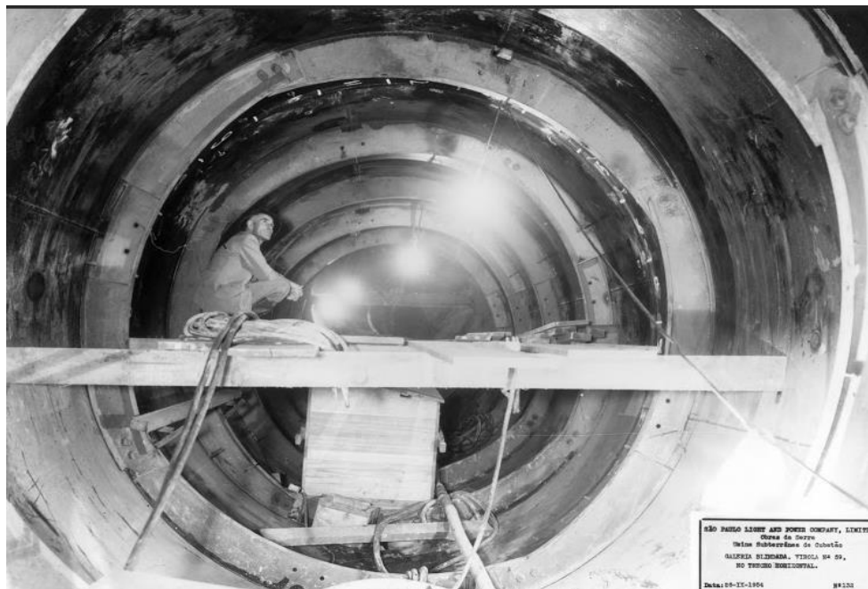
Galeria blindada da usina subterrânea pronta para descer em sua posição e já inserida na rocha, em 1954. Fonte: Acervo Fundação Energia e Saneamento
