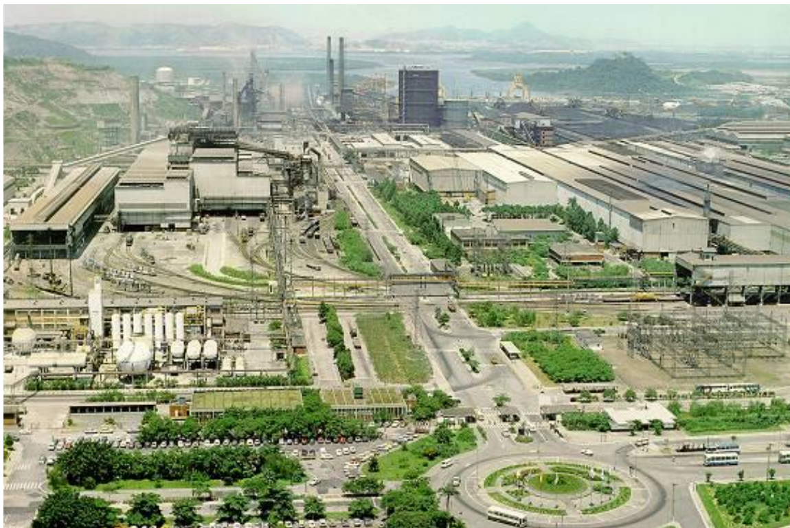
Figura 51 - Instalações da Usiminas em Cubatão
