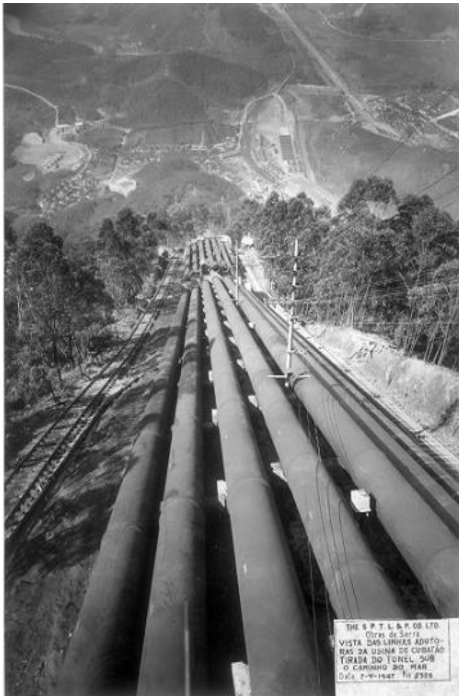
Os oito adutores, em 1947, por onde desce a água que movimenta as turbinas da Usina Henry Borden para geração de energia. Fonte: Acervo Fundação Energia e Saneamento
