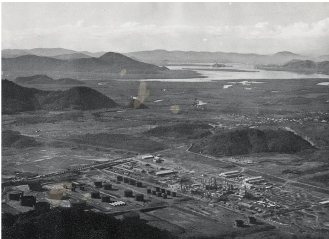
Figura 46 - Construção da Refinaria Presidente Bernardes por volta de 1950
