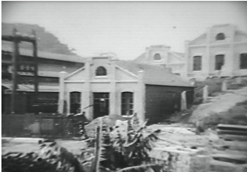
Figura 63 - Construção do prédio principal da Companhia Fabril, em 1922
