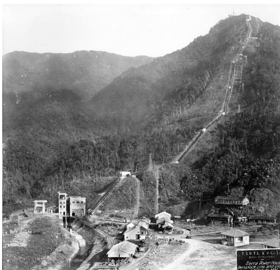
Figura 38 - Construção da Usina Externa e colocação das adutoras
