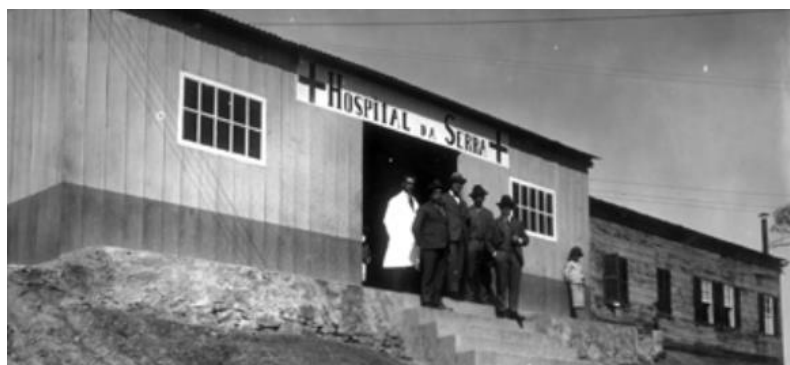
Figura 36 – Hospital da Serra, em 1926
