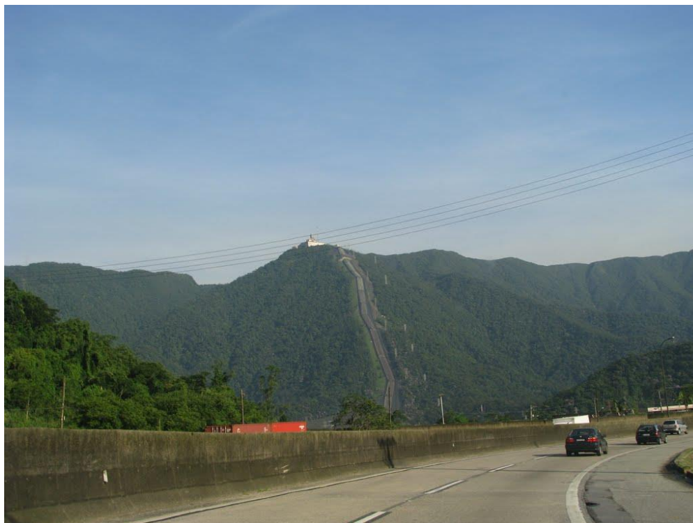
Figura 76 - Casa de força e adutoras da UHB vistas da Rodovia Anchieta
