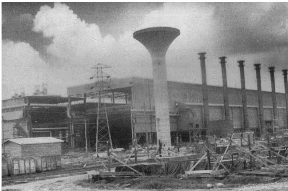
Figura 50 - Construção da Companhia Siderúrgica Paulista (Cosipa), 1950
