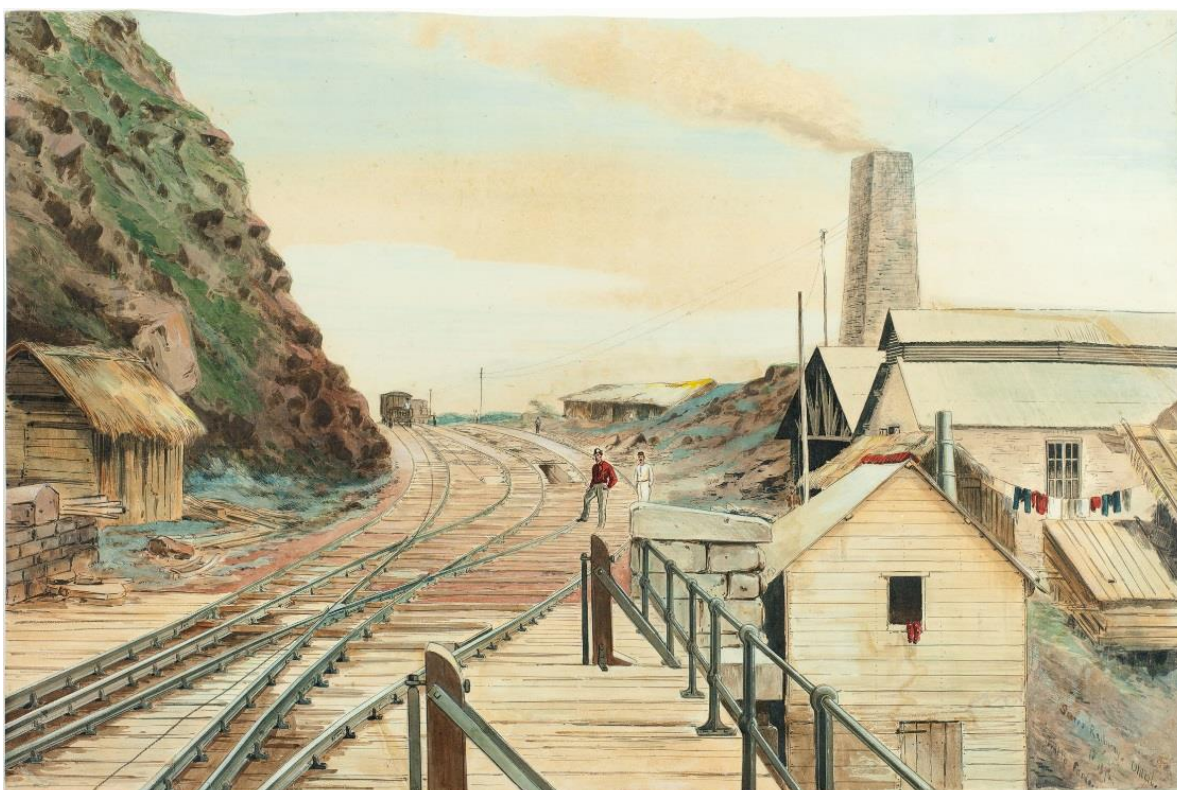
Figura 18 - Construção dos planos inclinados da Estrada de Ferro São Paulo Railway
