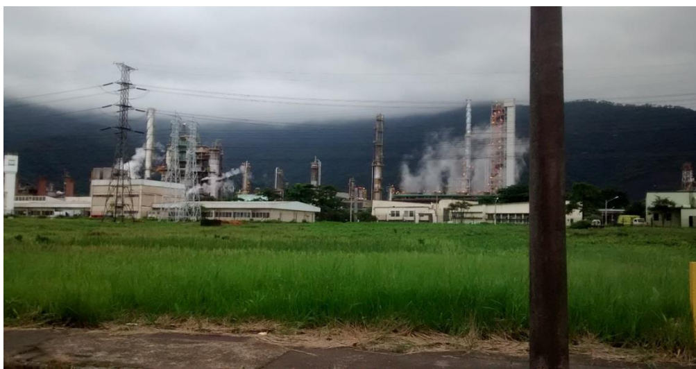
Figura 56 - Vista parcial da área industrial
