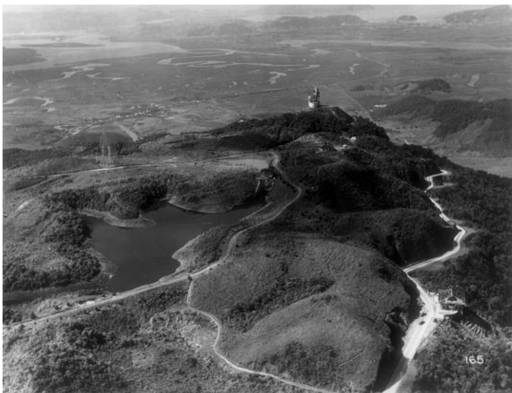
Figura 32 - Reservatório do Rio das Pedras e trecho do Caminho do Mar
