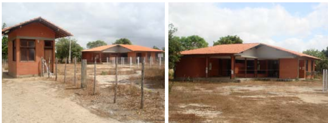
Figura 4.10 – Sede do IBAMA/Barreirinhas interditada no povoado do Cantinho.
