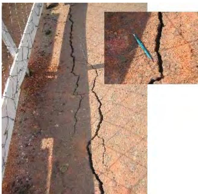
Figura 6.4 - Trincas nos revestimentos asfálticos das vias paralelas à escavação
