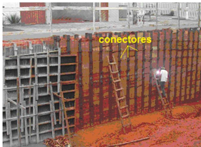
Figura 4.10 - Paredes de Concreto (Montagem das formas e solda dos conectores metálicos)
