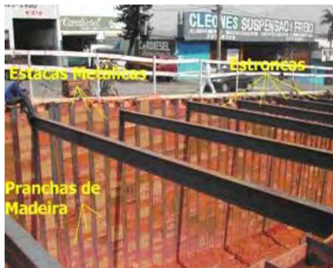
Figura 4.3 - Elementos da estrutura de contenção após a instalação das estroncas
