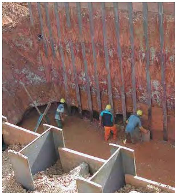
Figura 4.13 - Acúmulo de água do lençol e erosão na base do talude
