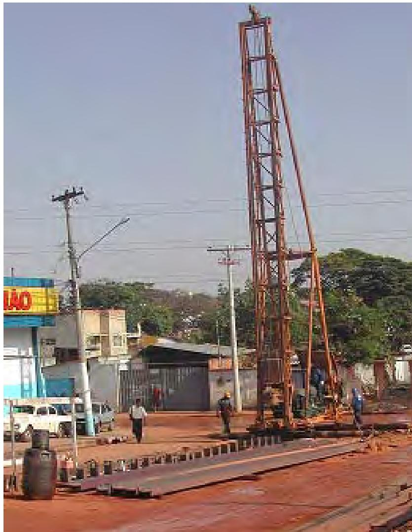
Figura 4.2 - Cravação das estacas metálicas com “Bate-Estacas”
