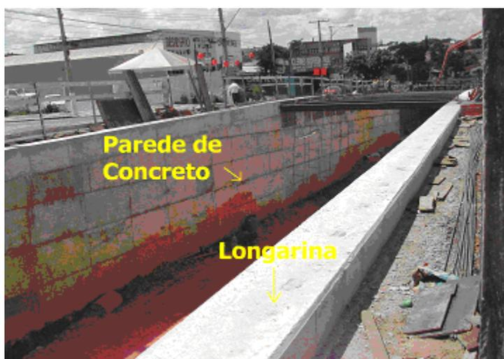
Figura 4.4 - Elementos da estrutura de contenção após a construção das paredes de concreto
