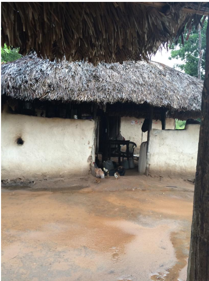
Figura 31: Casa de Seu Zezinho e Dona Tininha, Vão de Almas, mar. 2015. Fonte: a autora.
