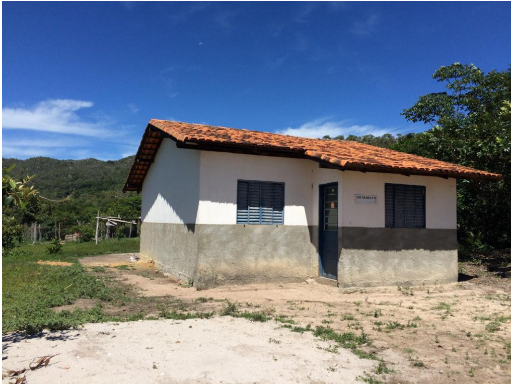
Figura 35: Casa de Rita, do Engenho II, construída pelo programa de moradias do Governo Federal, mar. 2015. Fonte: a autora.
