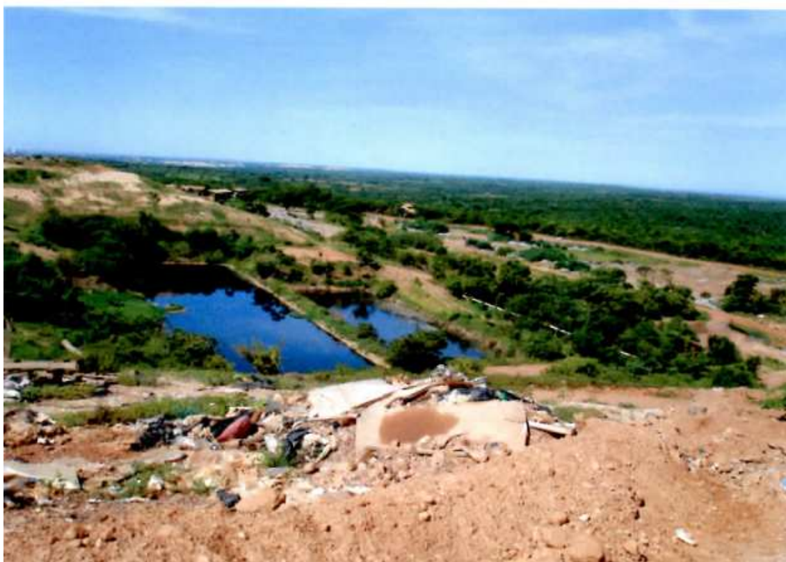
Figura 2.4- Lagoa de estabilização do chorume
