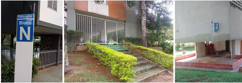
FIGURA 37 – Irregularidades: pilotis cercado e construções em pilotis.
